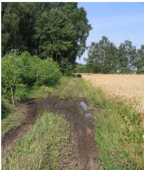
Fot. nr 48. Droga gruntowa w obrębie Grabowno Wielkie przewidziana do modernizacji.
