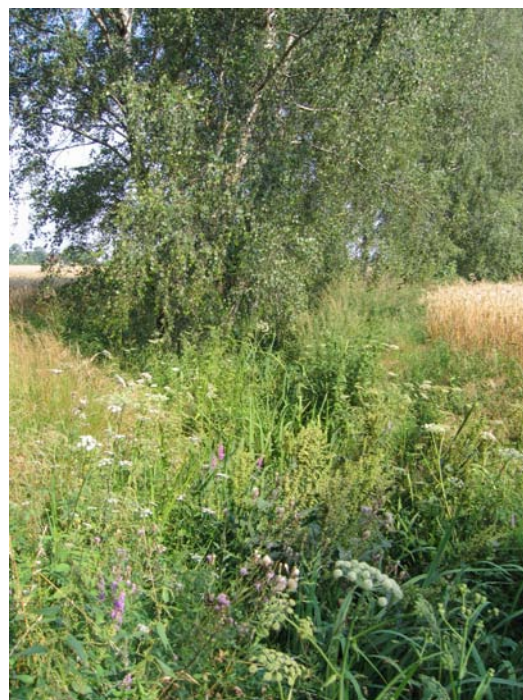
Fot. nr 30. Olszówka – ciek melioracji szczegółowej w złym stanie technicznym.
