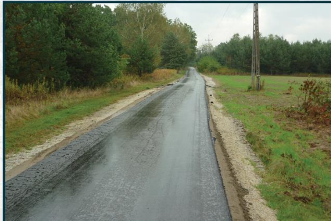
Wykonanie nawierzchni bitumicznej - Pajęczak wartość: 95 203,20 zł
