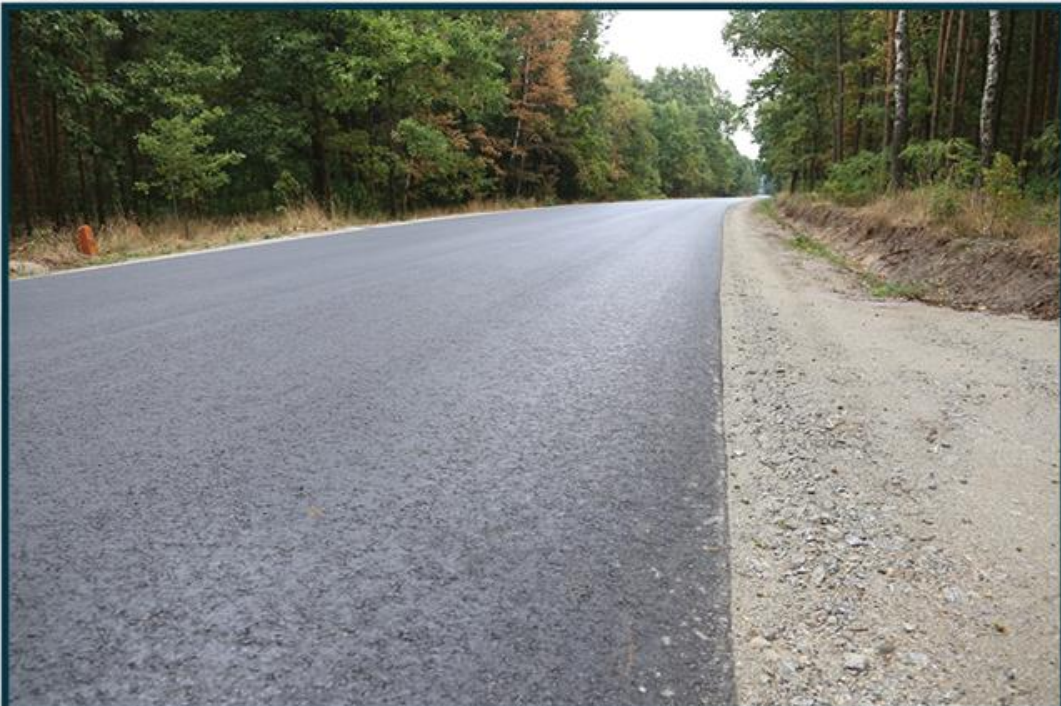
Przebudowa drogi powiatowej nr 1490 D w Goszczu - etap 3 dotacja Gminy Twardogóra: 120 352,18 zł Porozumienie z Powiatem Oleśnickim
