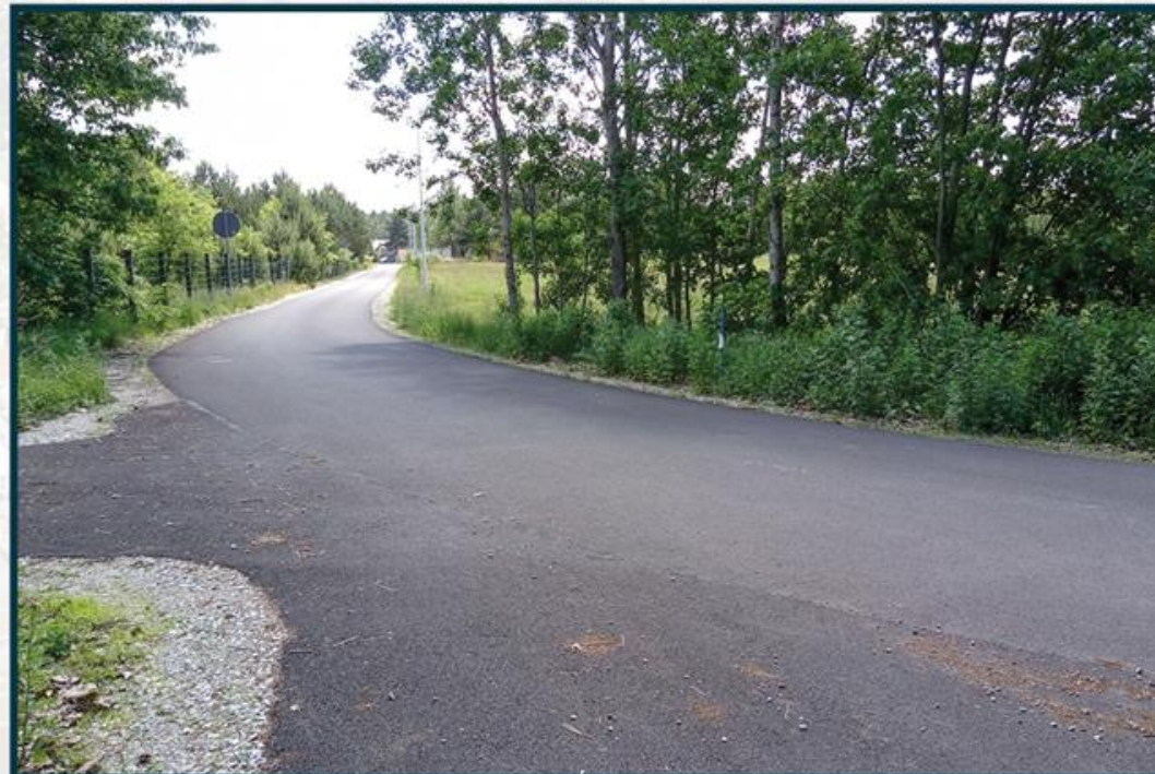
Przebudowa drogi gminnej nr 120304D w Sosnówce wartość: 634 067,66 zł dofinansowanie: 352 761,00 zł
