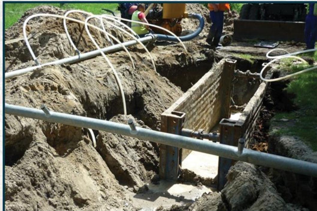
Budowa kanalizacji sanitarnej w miejscowości Goszcz i Grabowno Wielkie – etap 2 wartość: 1 261 533,38 zł dofinansowanie: 254 000,00 zł
