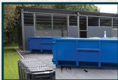
wiaty do gromadzenia odpadów, remont budynku garażowo-magazynowego, punkt przyjmowania rzeczy używanych, punkt napraw
