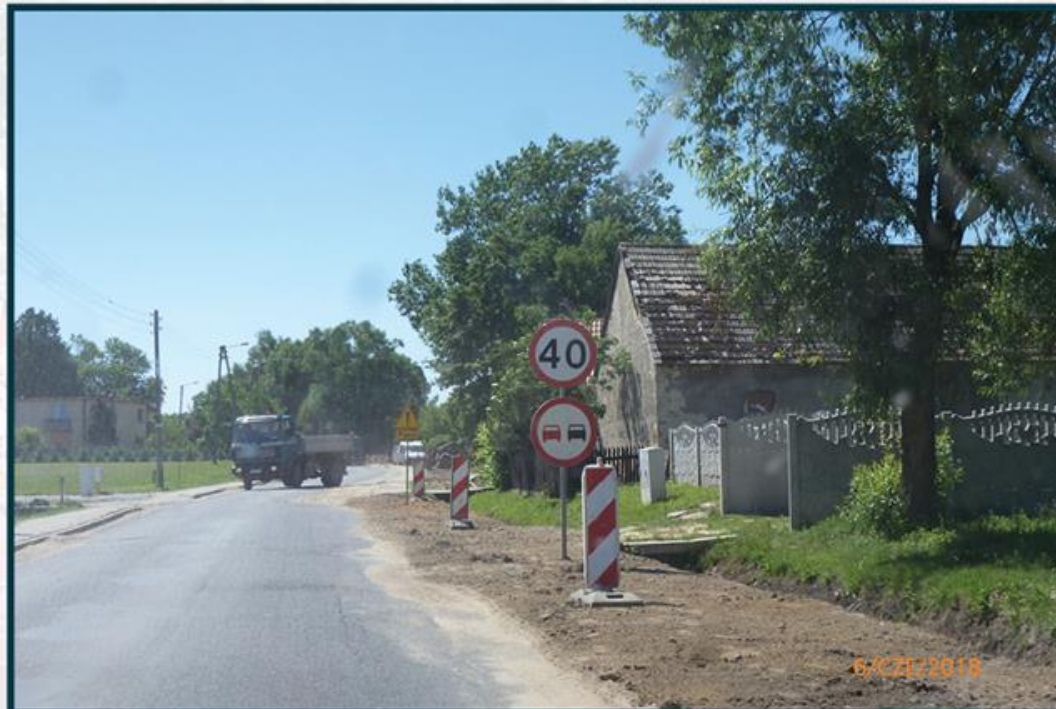
Budowa kanalizacji w Grabownie Małym - etap 1a wartość: 3 382 500,00 zł dofinansowanie: 1 999 374,00 zł
