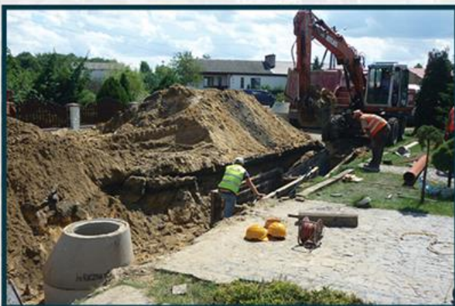
budowa przyłączy kanalizacyjnych
