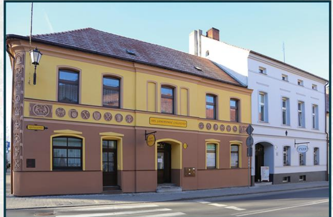
Remont budynku HPS ul. Ratuszowa 1a i 1b wartość: 412 528,77 zł dotacja Gminy Twardogóra: 299 860,59 zł
