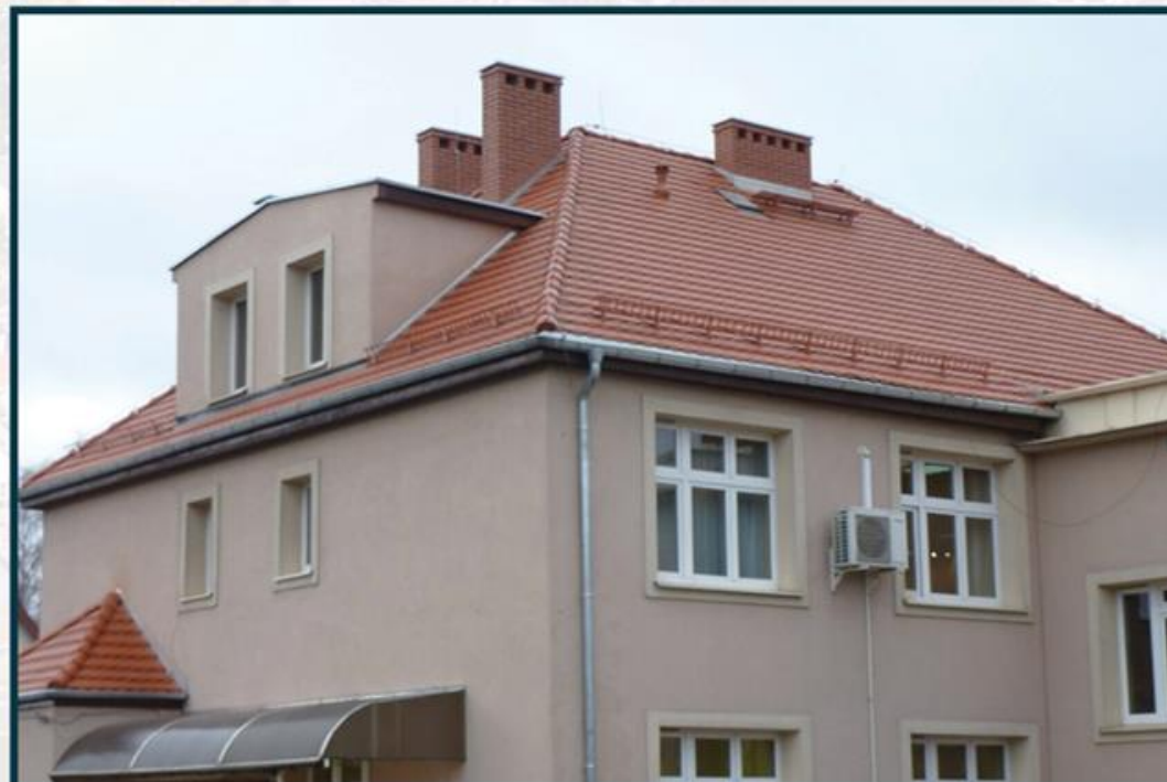
Przebudowa dachu budynku SZPZOZ w Twardogórze wartość: 113 844,41 zł
