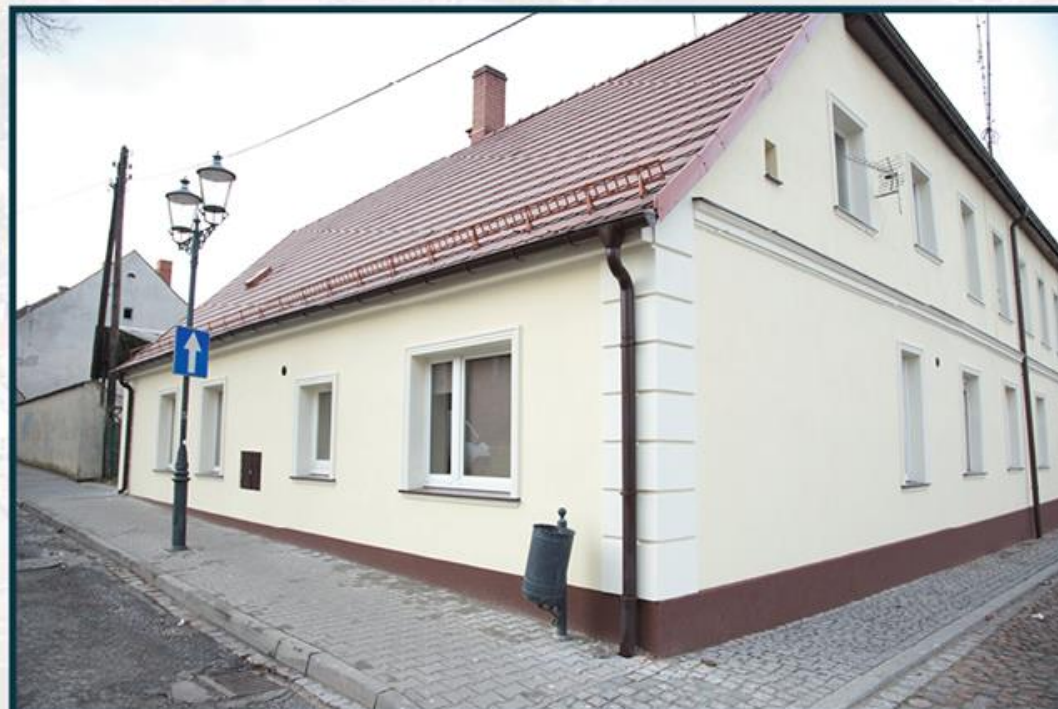
Remont elewacji budynków mieszkalnych przy pl. Piastów 17 i ul. Krótkiej 1 wartość: 118 800,00 zł środki ZGKiM
