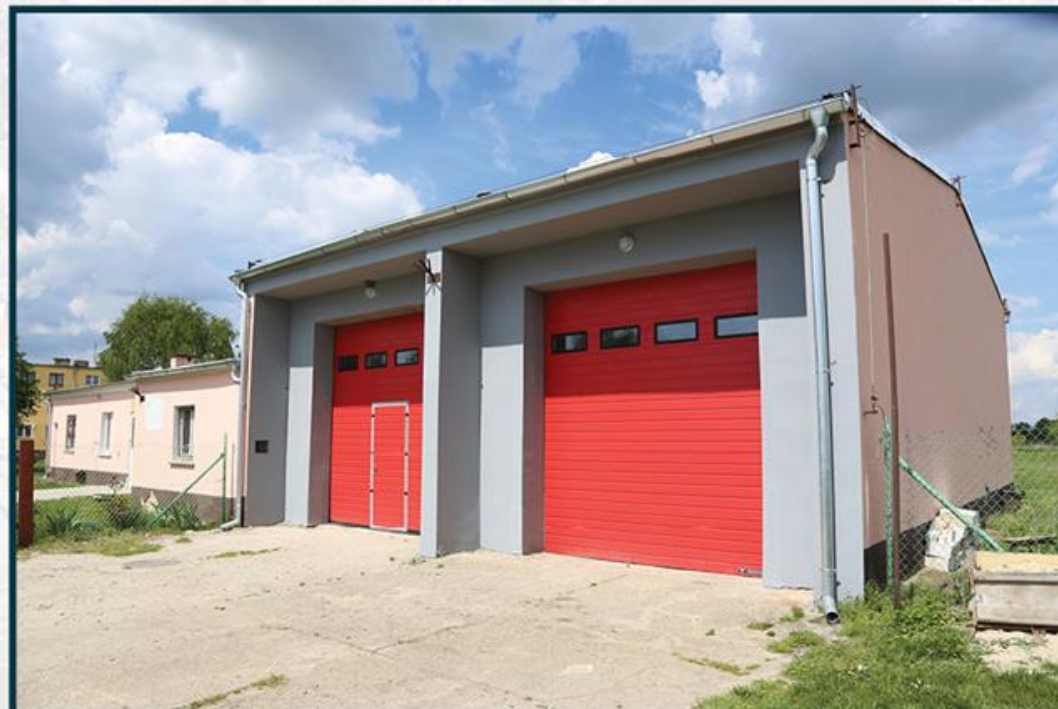
Remont dachu budynku OSP w Grabownie Wielkim wartość: 47 970,00 zł
