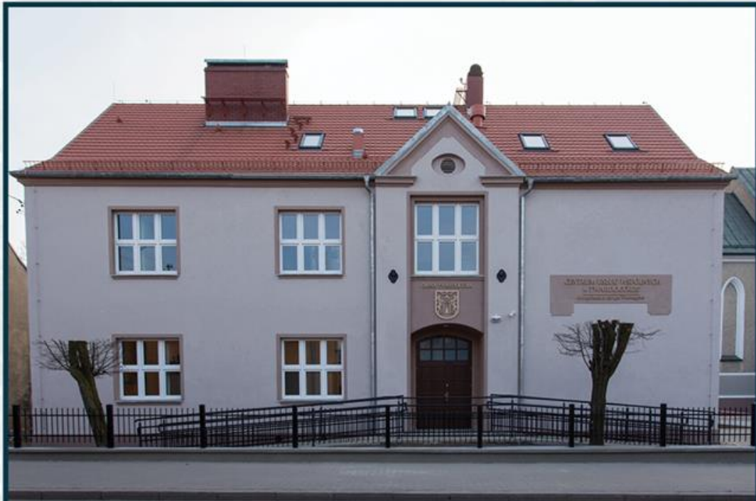
Remont budynku przy ul. 1-go Maja wartość: 1 303 839,21 zł
