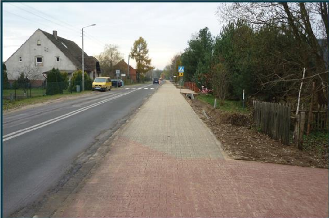
Budowa ścieżki pieszo-rowerowej w Sosnówce wartość: 312 688,56 zł
