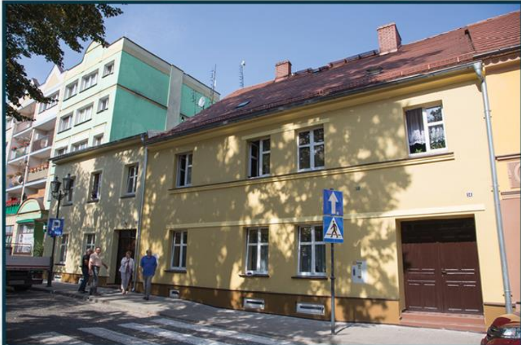
Remont budynków przy Placu Piastów 13 i 14 wartość: 109 899,00 zł środki ZGM
