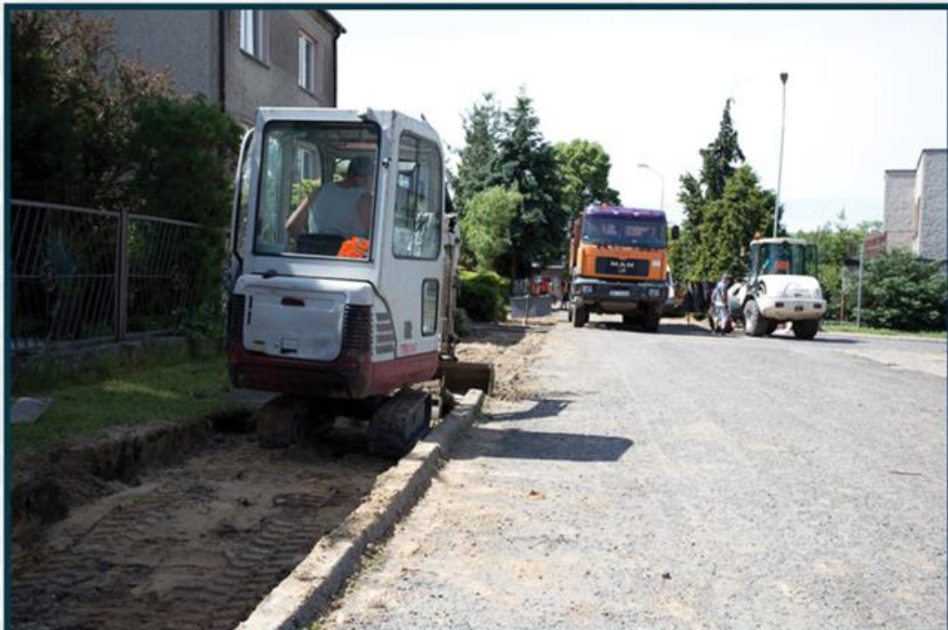
Budowa chodników wzdłuż ulic: Szkolnej, Staszica i Kołtątaja w Twardogórze wartość: 227 821,20 zł
