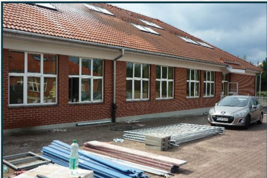
Przebudowa dachu w budynku Gimnazjum i SP nr 2 w Twardogórze wartość: 474 466,47 zł
