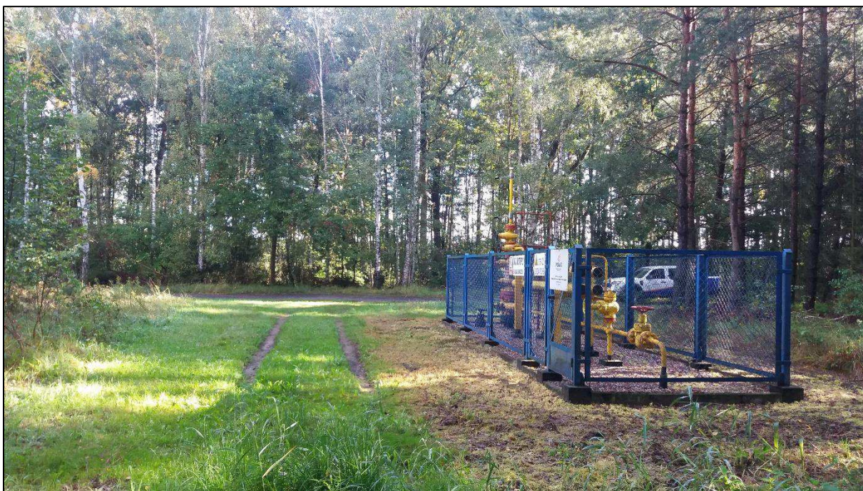
Fot. 2. Dojazd do terenu wiertni.
