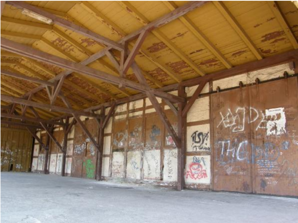
rampa od strony torów kolejowych
