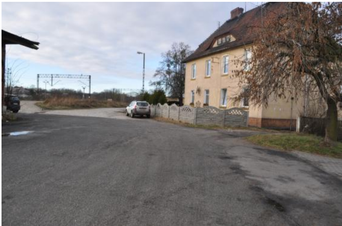
Stan istniejący nawierzchni z betonu asfaltowego wokół dworca kolejowego w Twardogórze
