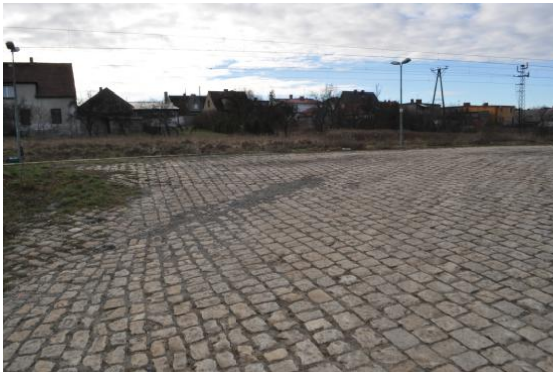
Stan istniejący nawierzchni z kostki kamiennej wokół dworca kolejowego w Twardogórze
