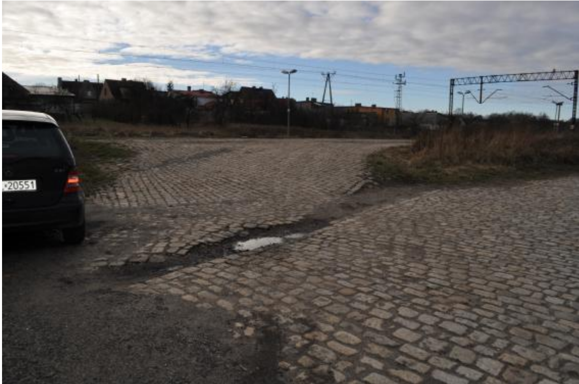
Stan istniejący nawierzchni wokół dworca kolejowego w Twardogórze
