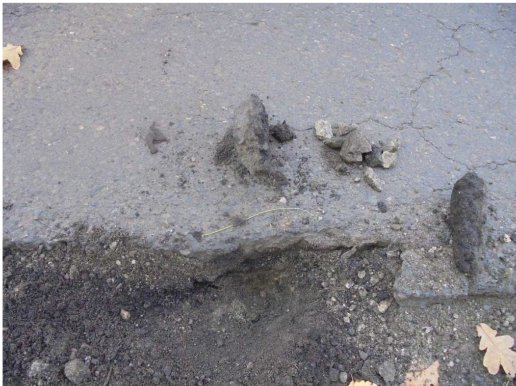
Odwiert nr 10 5cm bitum, 15cm łuczeń granitowy, piasek
