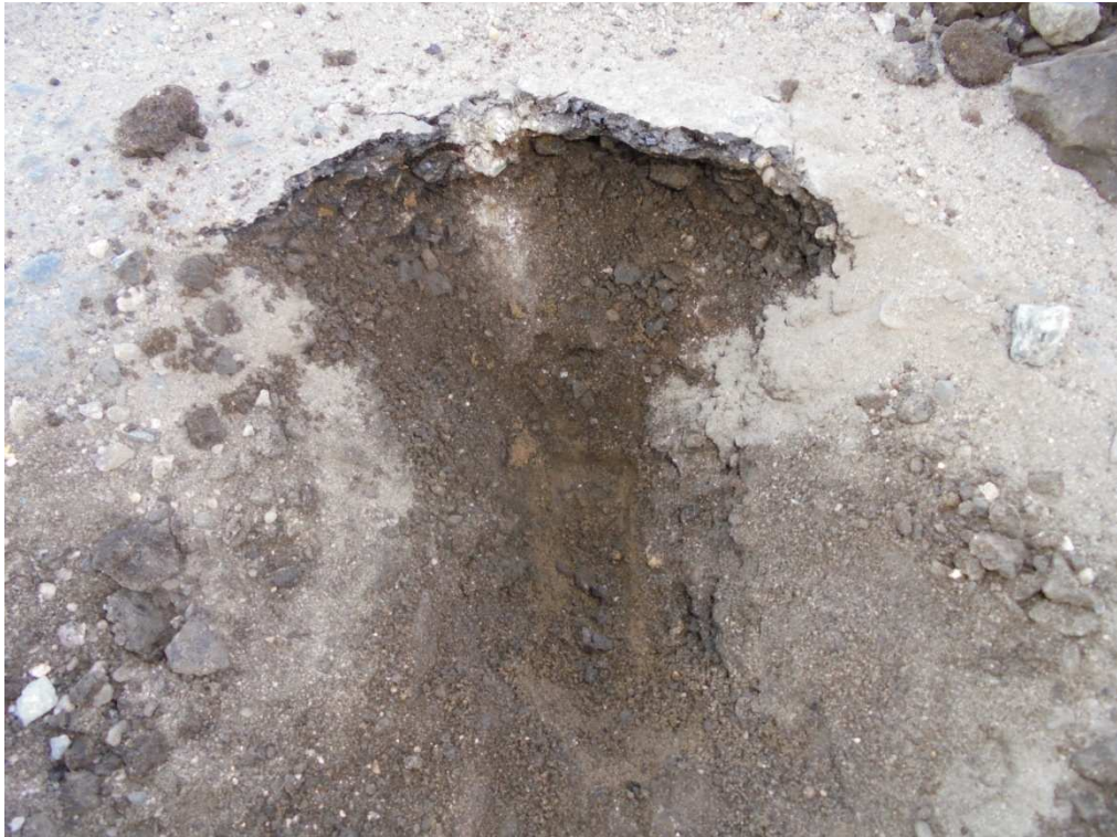
Odwiert nr 2 3cm bitum, 9cm tłuczeń, piasek
