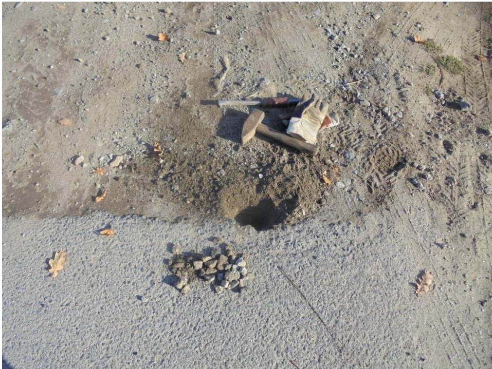
Odwiert nr 5 3-5cm bitum, 8-9cm tłużeń granitowy,
