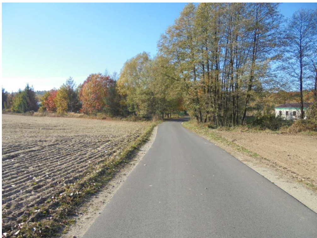
Stan istniejący pasa drogi gminnej
