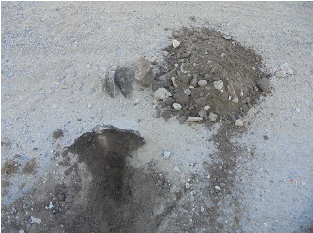
Odwiert nr 2 3cm bitum, 9cm tłuczeń, piasek
