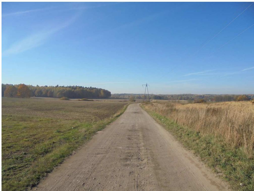
Stan istniejący pasa drogi gminnej
