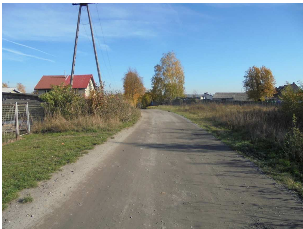
Stan istniejący pasa drogi gminnej
