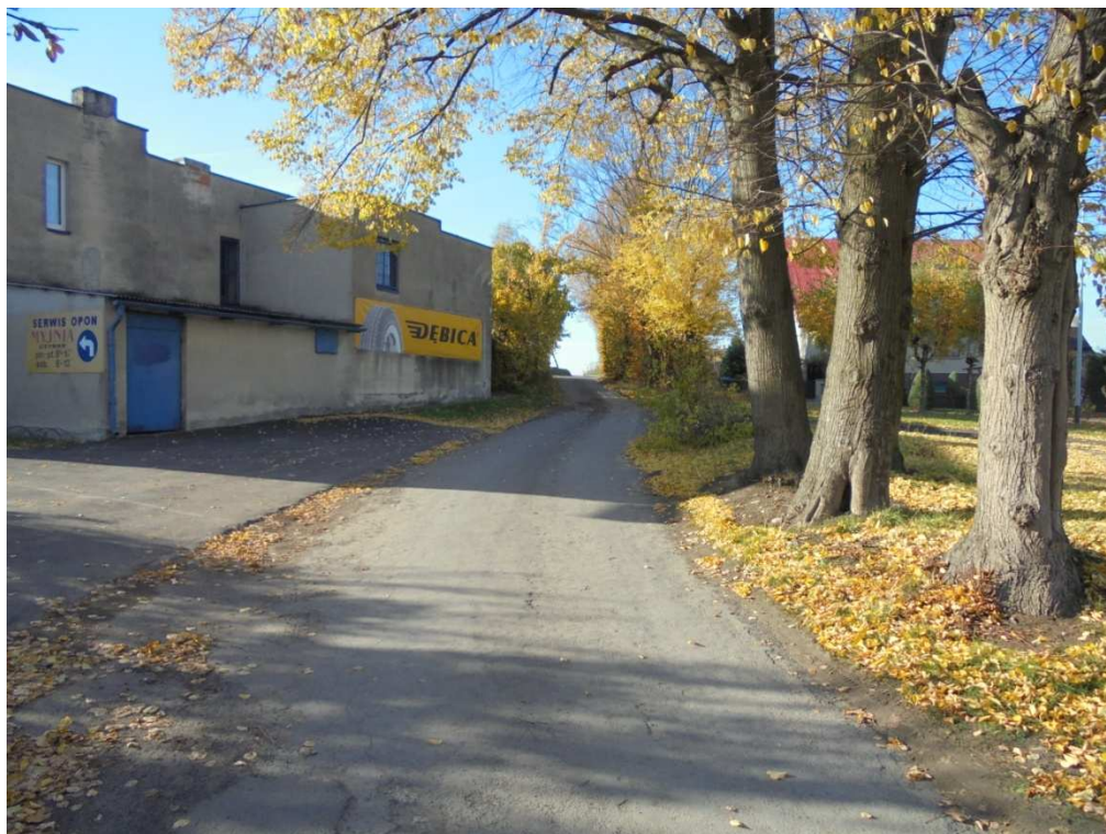
Stan istniejący pasa drogi gminnej
