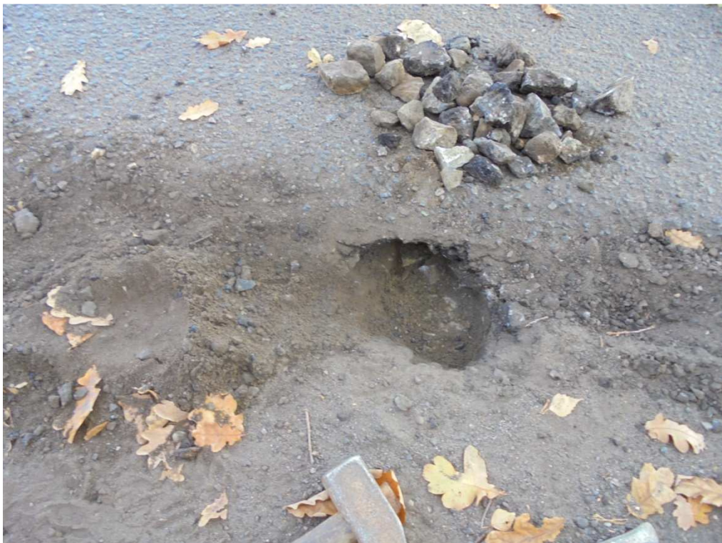
Odwiert nr 9 9cm bitum, 20cm tłuczeń granitowy/kamień polny
