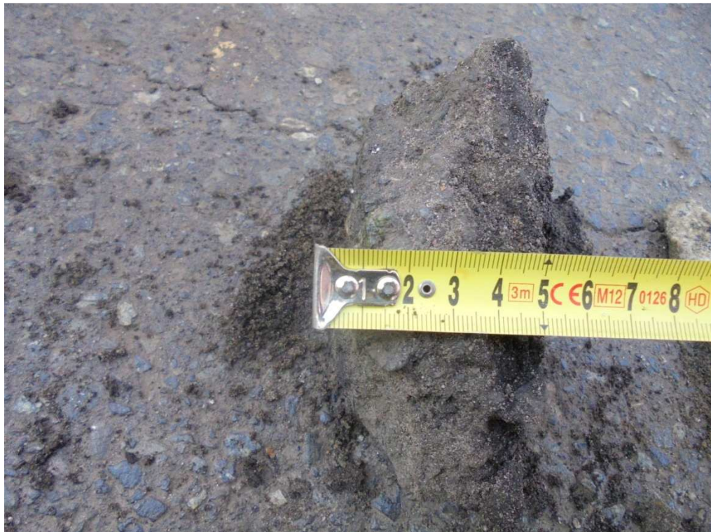
Odwiert nr 10 5cm bitum
