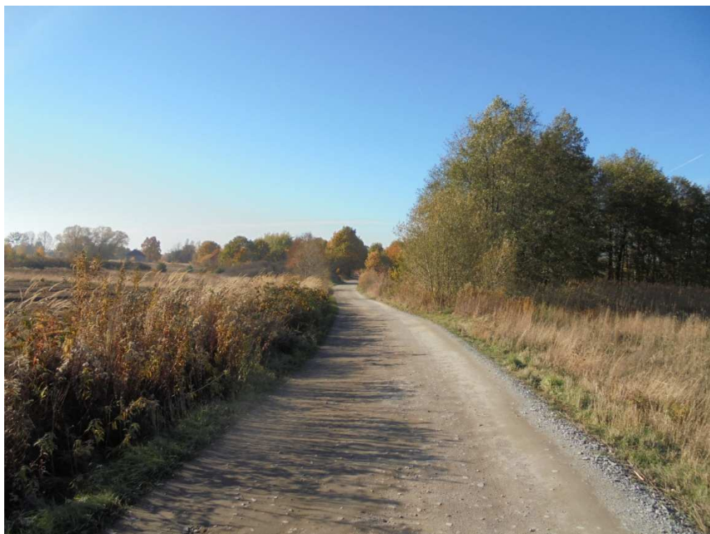
Stan istniejący pasa drogi gminnej
