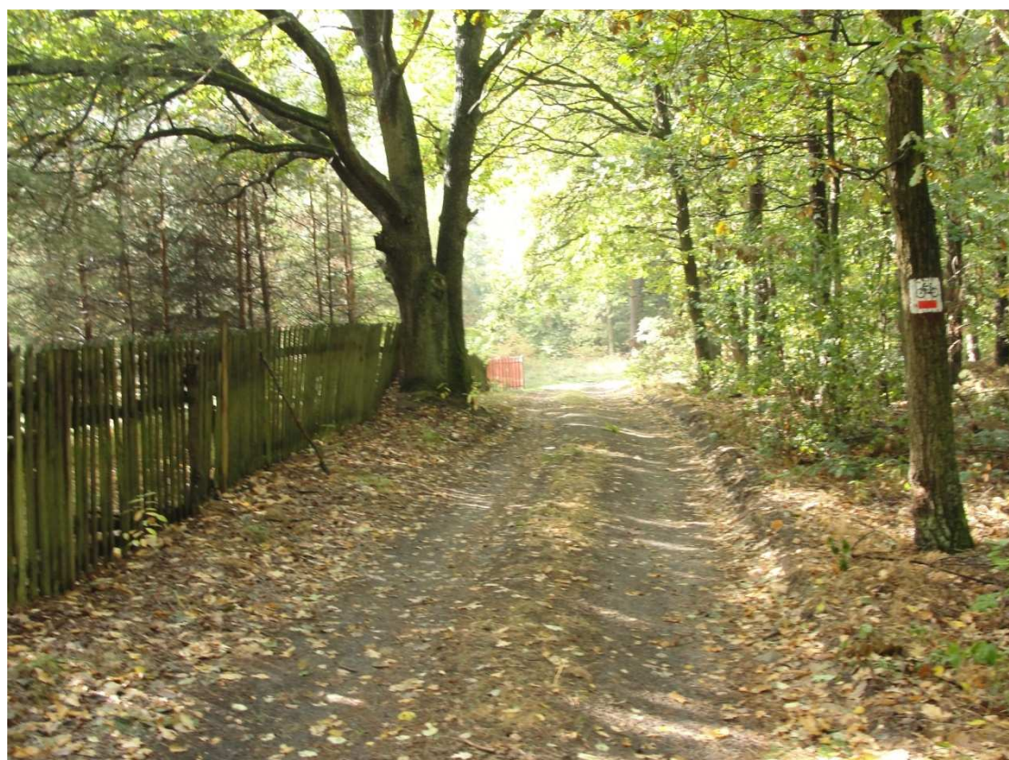
Stan istniejący nawierzchni drogi gminnej 120304 D Koniec Zakresu Opracowania
