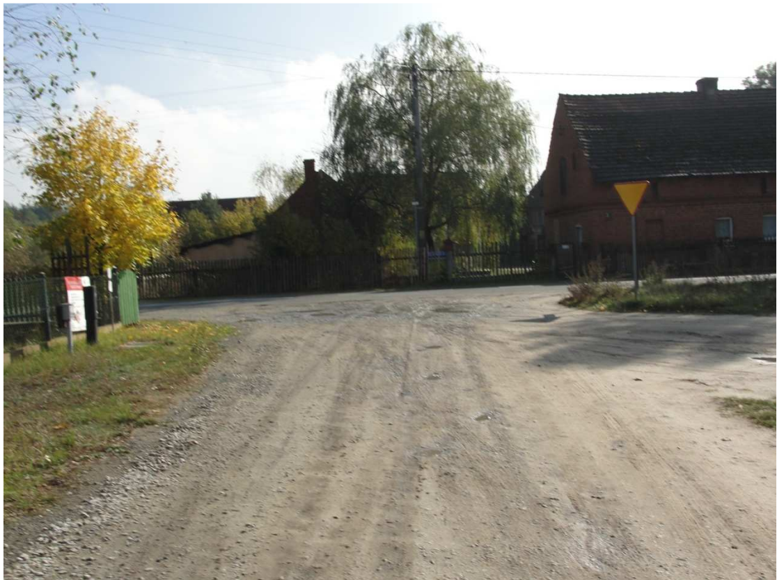
Stan istniejącej nawierzchni drogi gminnej 120304 D Początek Zakresu Opracowania
