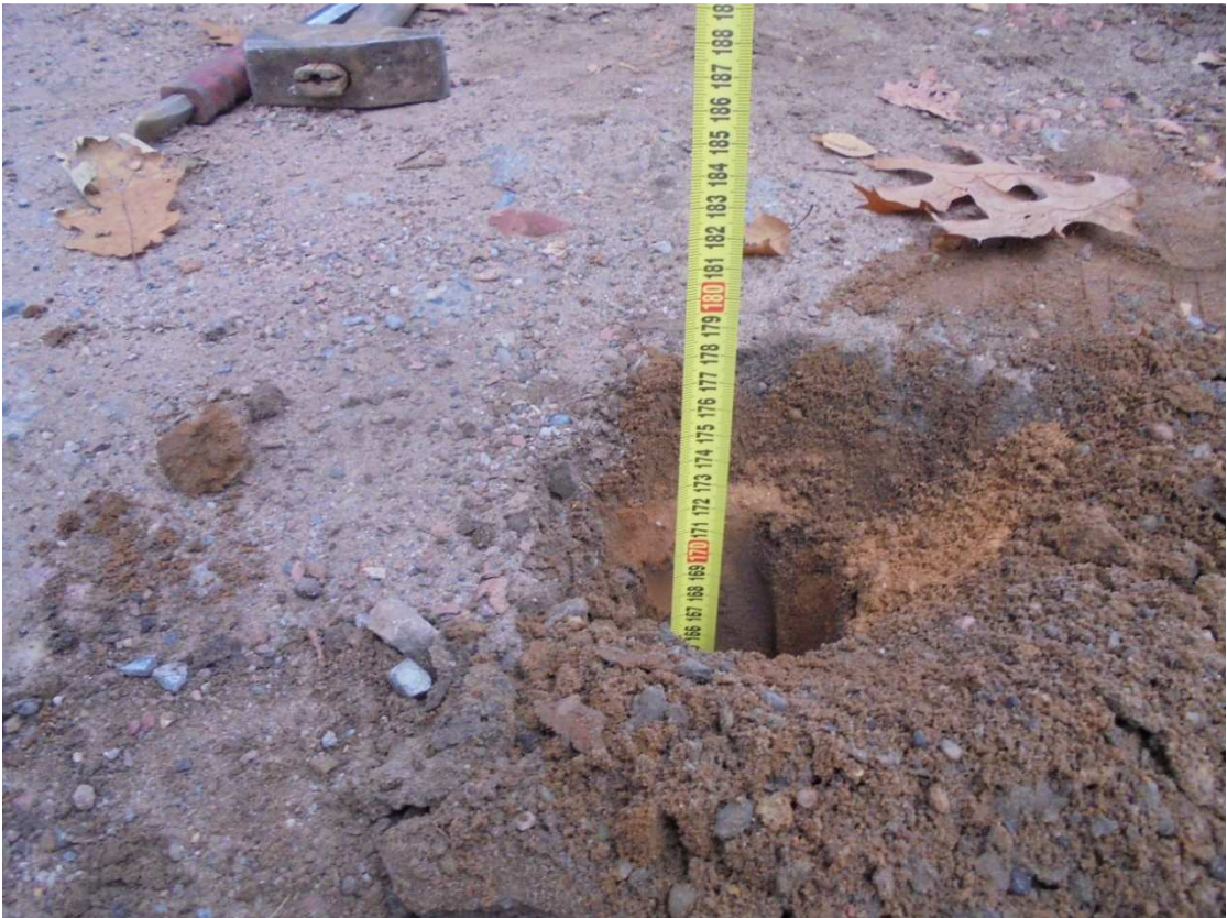
Odwiert nr 3 90cm nasyp budowlany/ziemia, 80cm piasek
