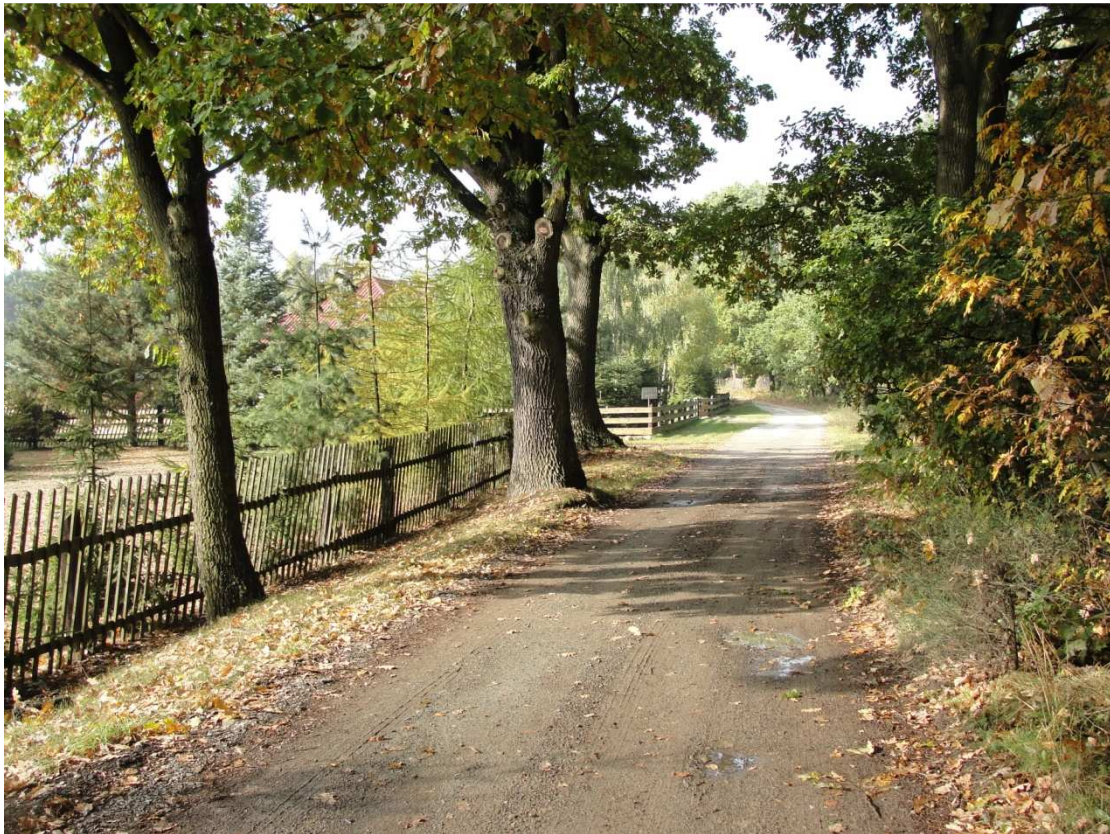
Stan istniejący nawierzchni drogi gminnej120304D
