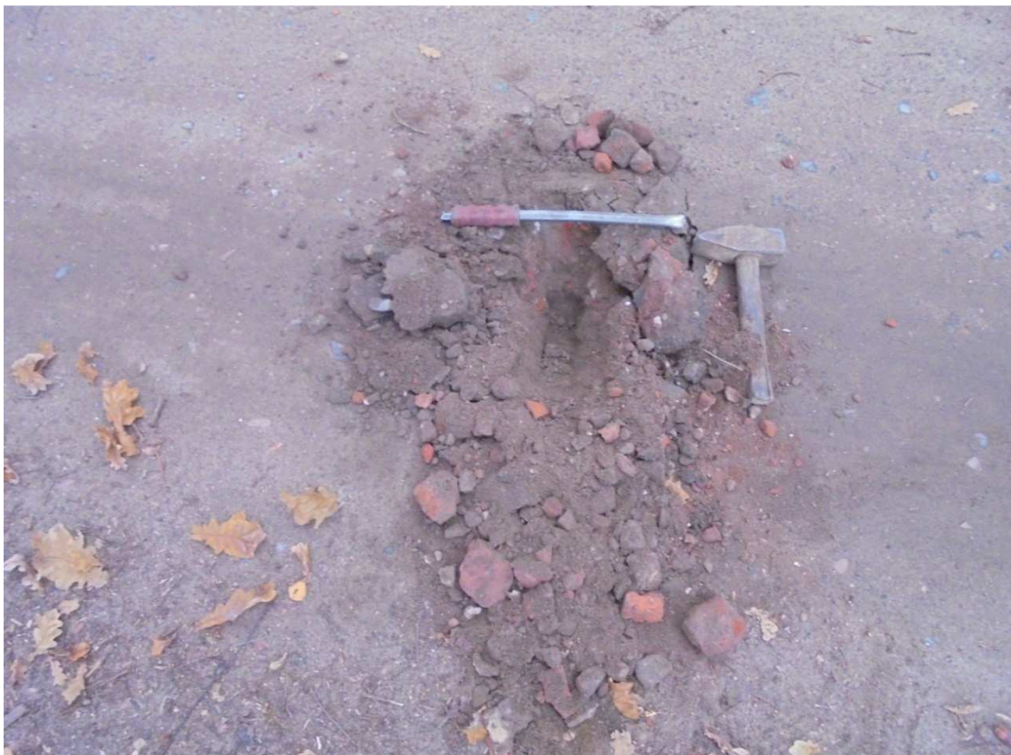
Odwiert nr 4 5cm tłuczeń, 17cm gruz/cegła
