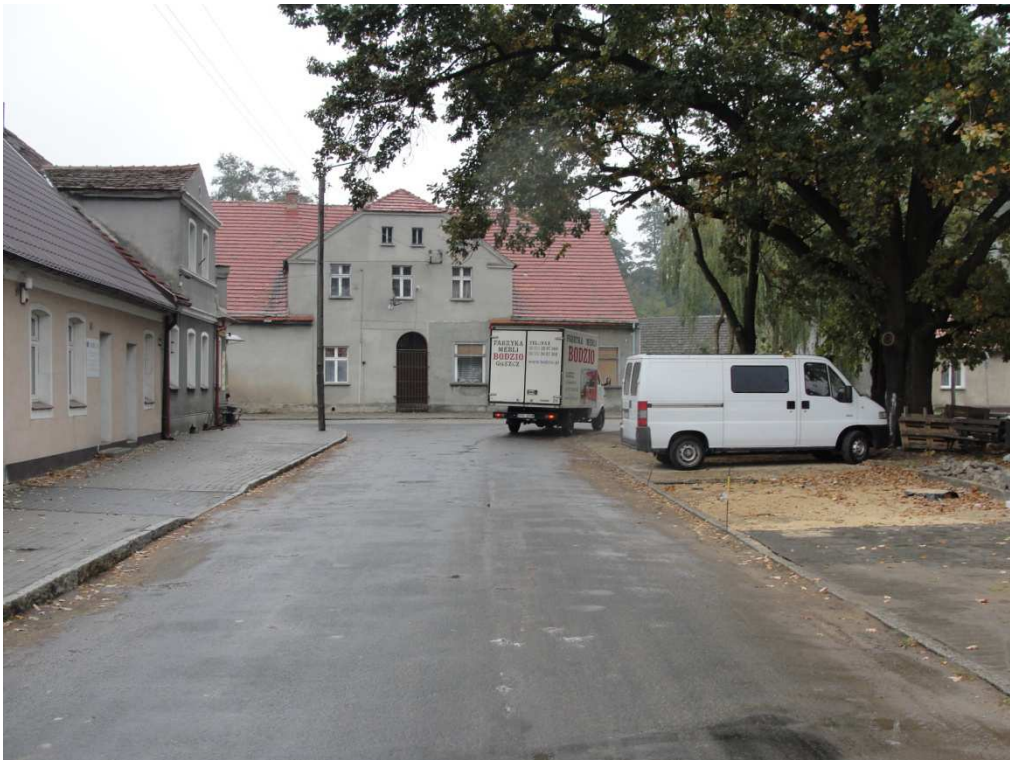
Stan istniejący pasa drogi gminnej ul. W. Korfanteo
