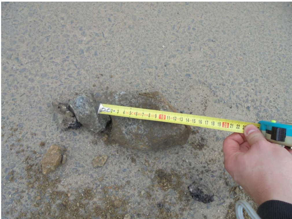
Odwiert nr 7- ul. Rynek od strony DW Nr 448 4 cm nawierzchnia bitumiczna, 10cm piasek/drobny granit, grunty piaszczyste z lokalnymi przewarstwieniami pasków pylastych
