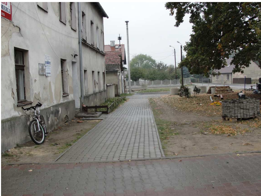
Stan istniejący nawierzchni Plac przy ul. W. Korfanteo
