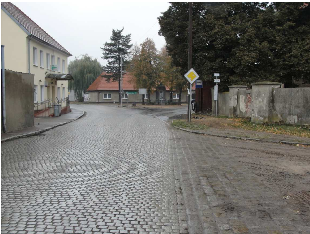
Stan istniejący pasa drogowego drogi wojewódzkiej Nr 448 miejscowość Goszcz Początek Zakresu Opracowania
