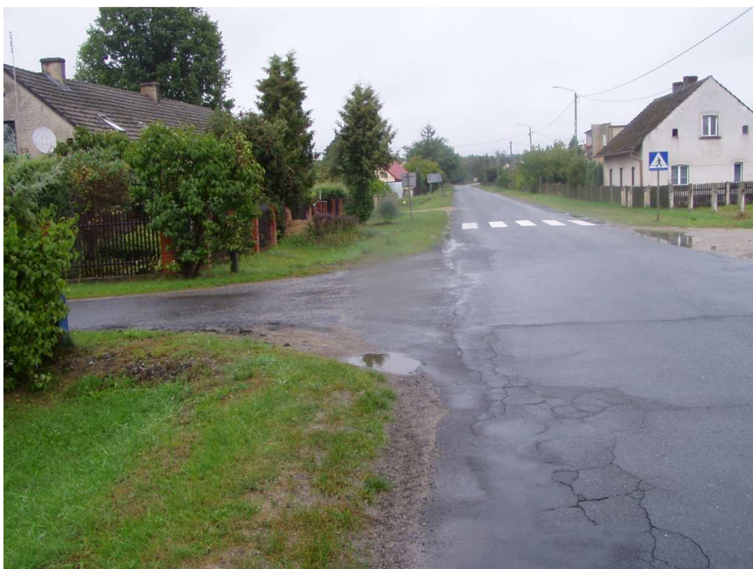
pas drogowy drogi powiatowej nr 1470 D km 0+200 miejscowość Sosnówka – strona L
