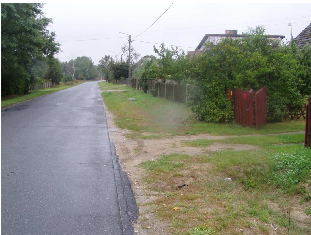
pas drogowy drogi powiatowej nr 1470 D km 0+350 miejscowość Sosnówka – strona P
