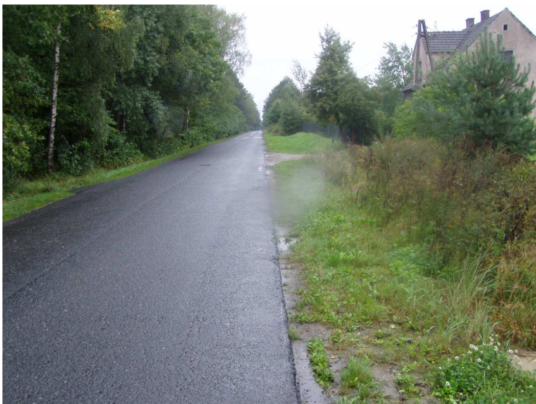
pas drogowy drogi powiatowej nr 1470 D km 1+720 teren niezabudowany – strona L
