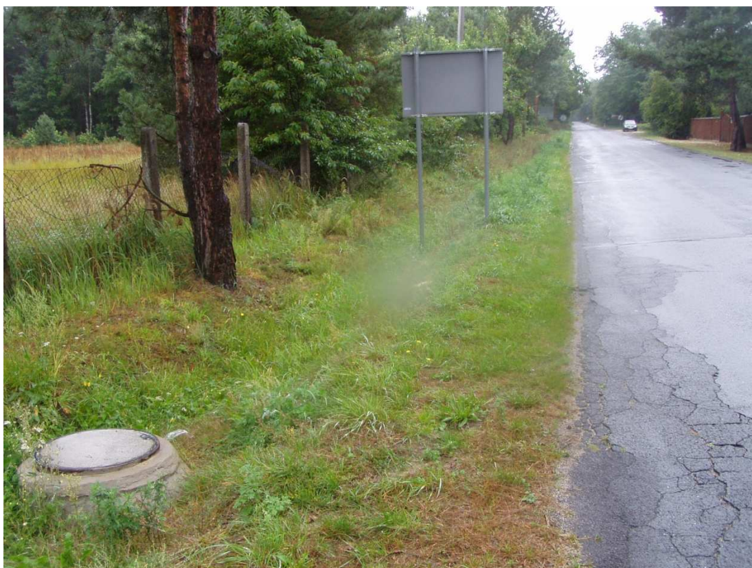
pas drogowy drogi powiatowej nr 1470 D km 0+140 miejscowość Sosnówka – strona P
