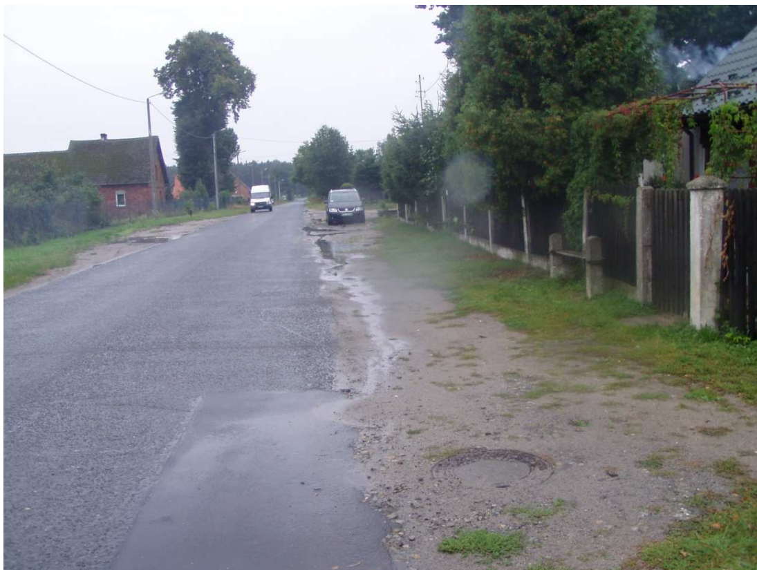
pas drogowy drogi powiatowej nr 1470 D km 2+300 miejscowość Drogoszowice – strona L
