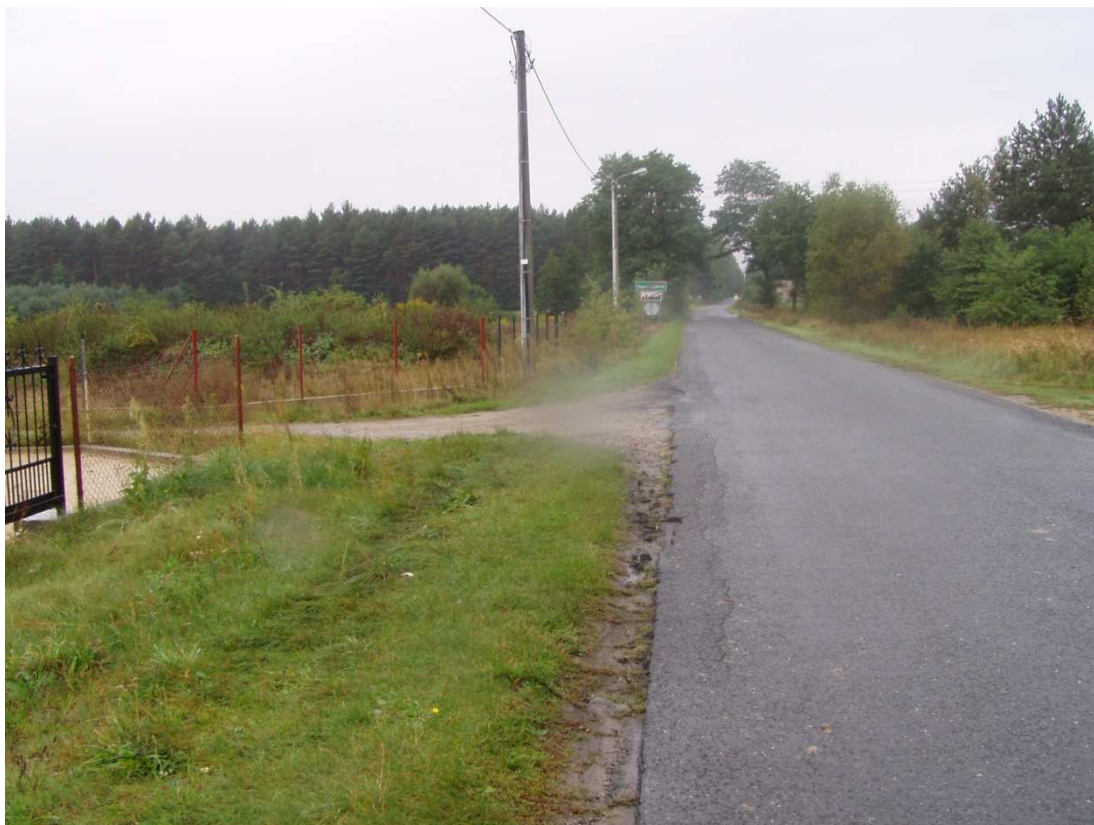
pas drogowy drogi powiatowej nr 1470 D km 1+950 miejsowość Drogoszowice – strona P
