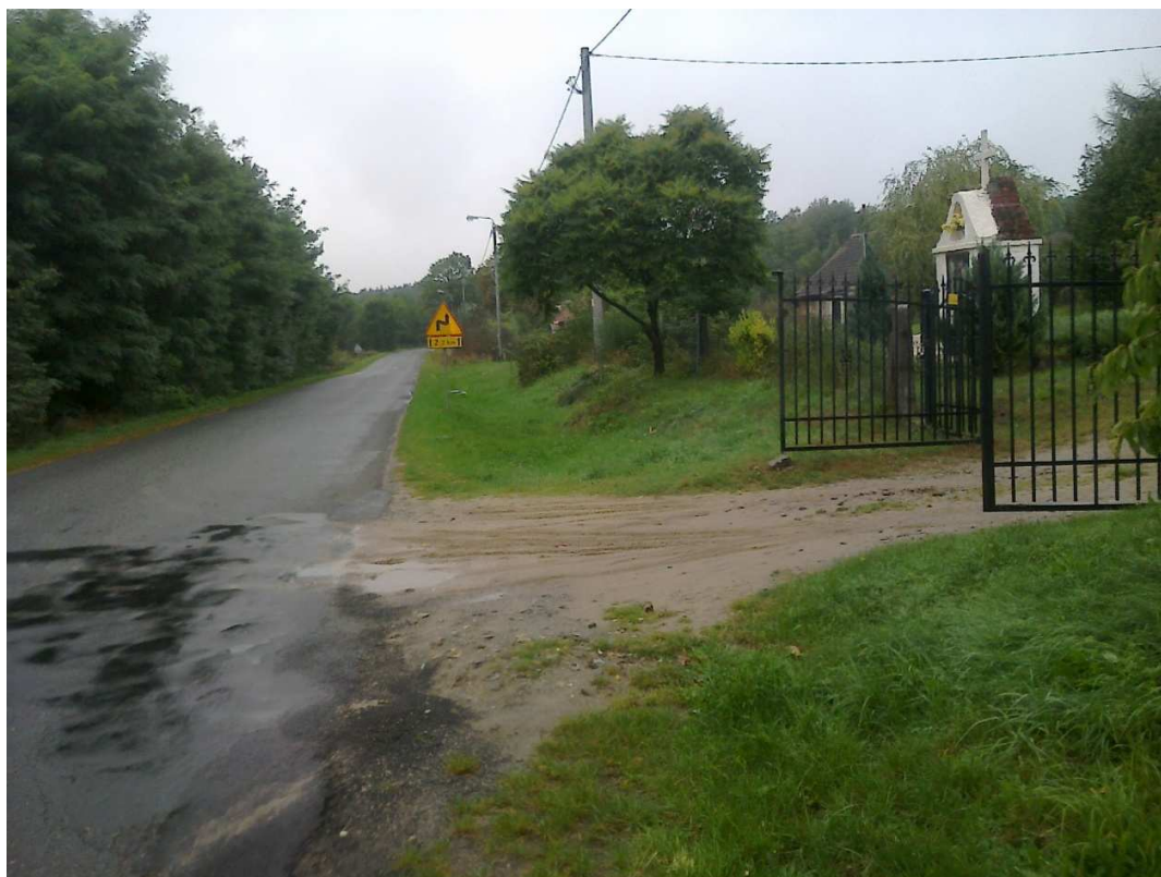
pas drogowy drogi powiatowej nr 1470 D km 3+250 str. P miejscowość Drogoszowice
