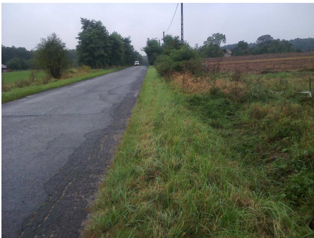
pas drogowy drogi powiatowej nr 1470 D km 3+100 str. P miejsowość Drogoszowice
