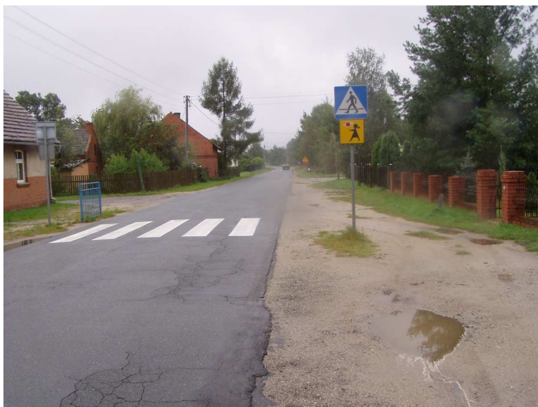
pas drogowy drogi powiatowej nr 1470 D km 0+700 miejscowość Sosnowka – strona L
