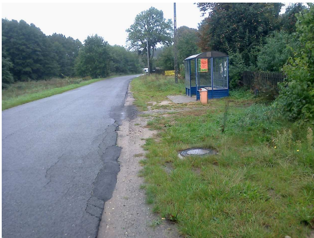
pas drogowy drogi powiatowej nr 1470 D km 3+400 str. P miejscowość Drogoszowice
