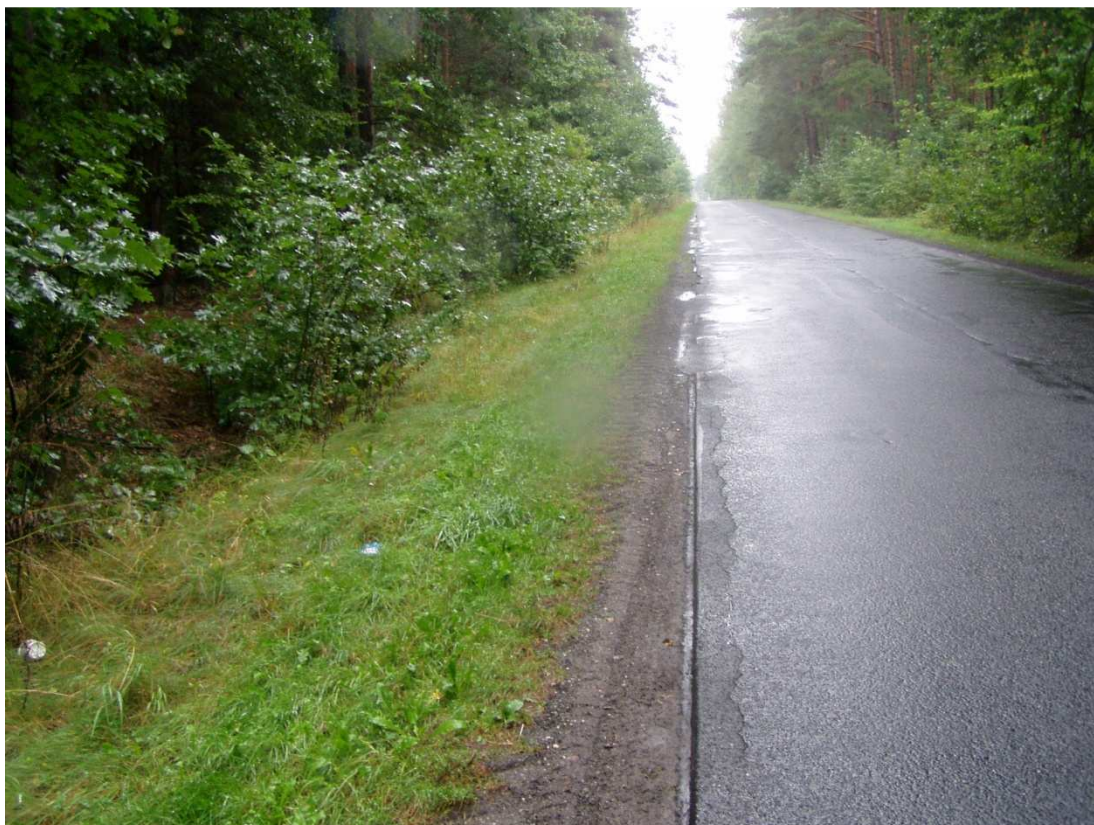
pas drogowy drogi powiatowej nr 1470 D km 1+050 teren niezabudowany – strona L
