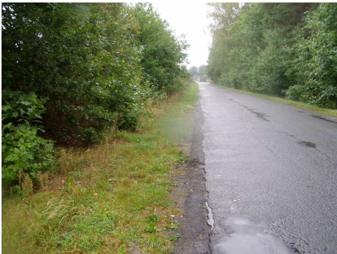
pas drogowy drogi powiatowej nr 1470 D km 1+500 teren niezabudowany – strona L
