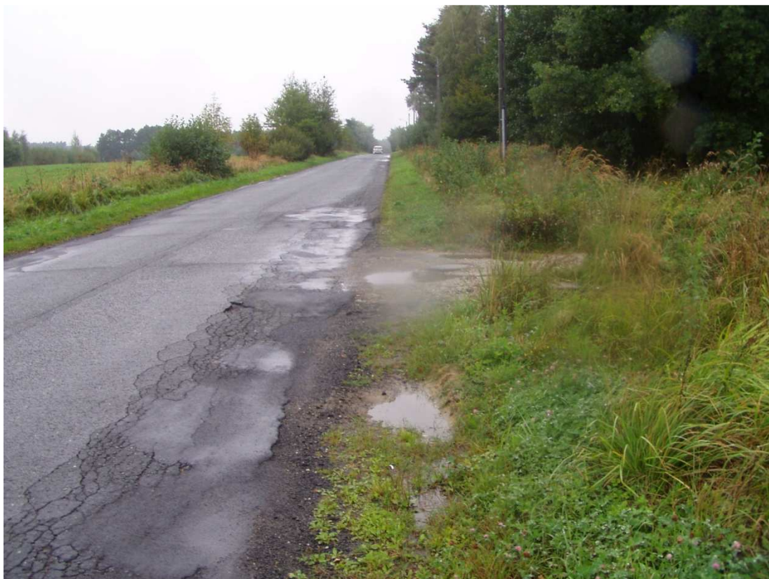
pas drogowy drogi powiatowej nr 1470 D km 2+900 str. P miejsowość Drogoszowice
