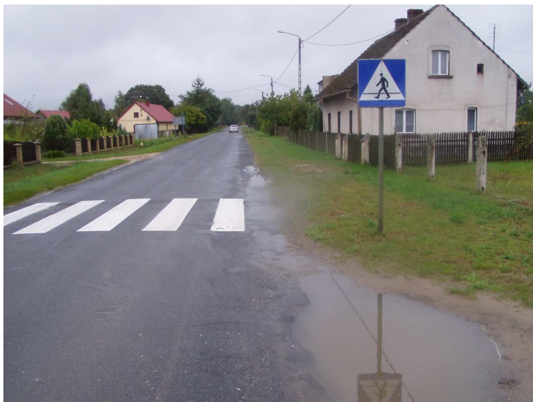
pas drogowy drogi powiatowej nr 1470 D km 0+200 miejscowość Sosnówka – strona P
