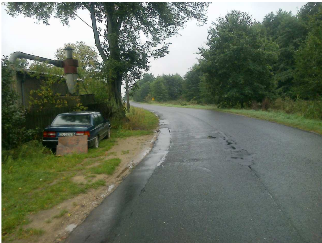
pas drogowy drogi powiatowej nr 1470 D km 3+440str. P miejsowość Drogoszowice
