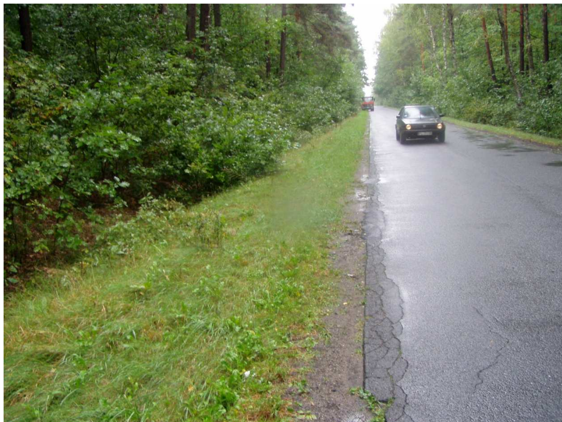
pas drogowy drogi powiatowej nr 1470 D km 1+000 teren niezabudowany – strona L
