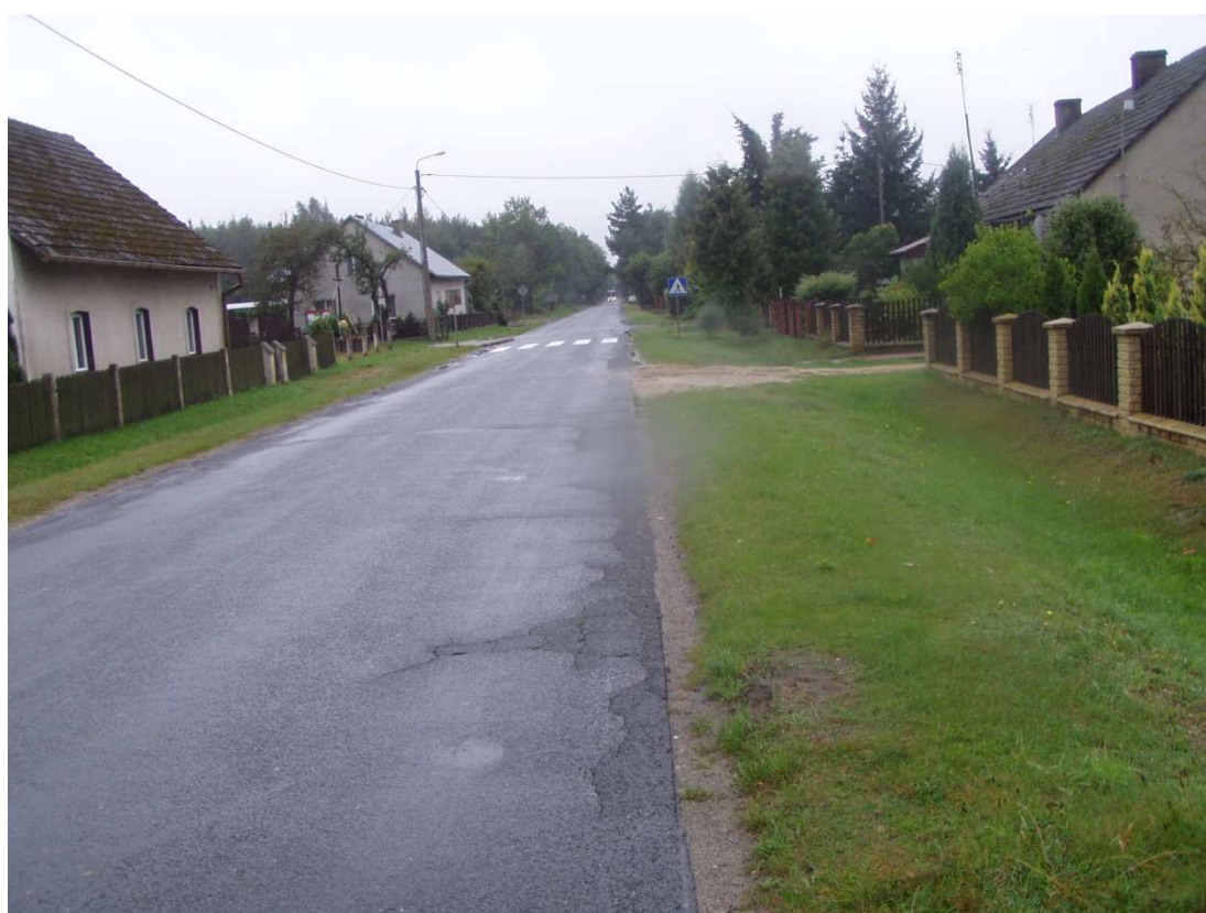
pas drogowy drogi powiatowej nr 1470 D km 0+240 miejscowość Sosnówka – strona L
