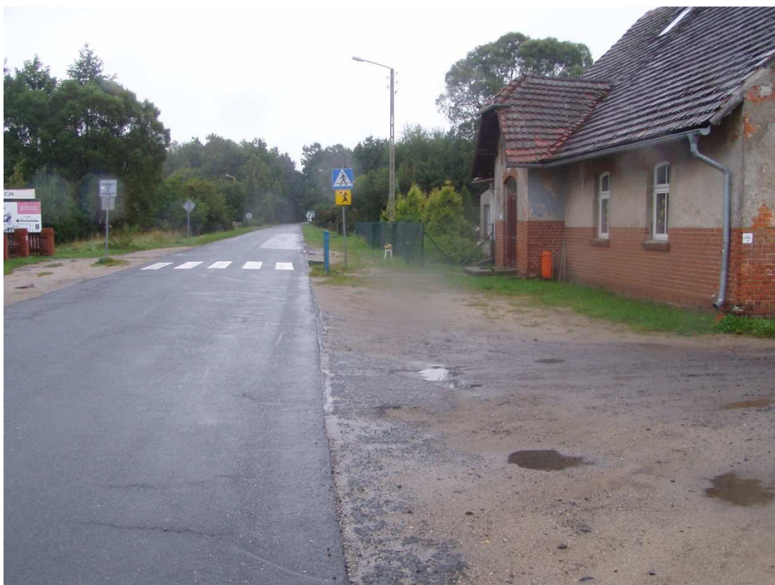
pas drogowy drogi powiatowej nr 1470 D km 0+700 miejscowość Sosnowka – strona P
