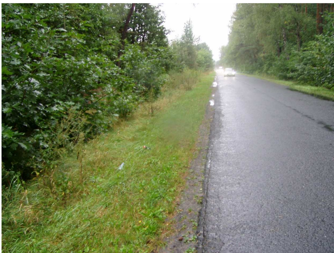
pas drogowy drogi powiatowej nr 1470 D km 1+200 teren niezabudowany – strona L
