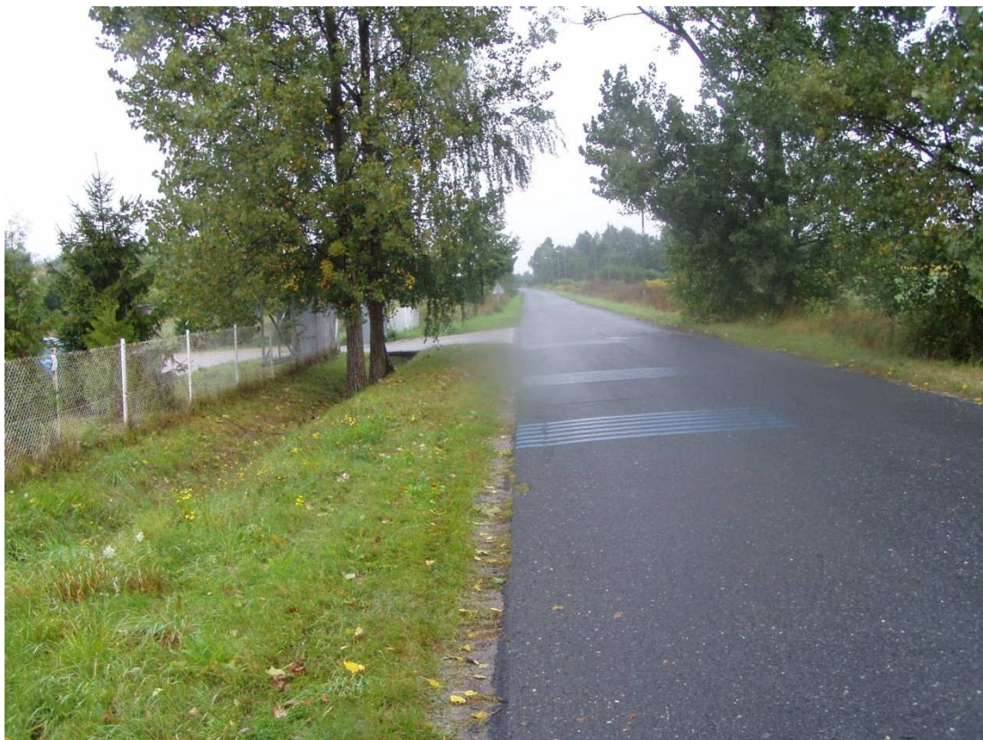
pas drogowy drogi powiatowej nr 1470 D km 2+560 str. L miejsowość Drogoszowice
