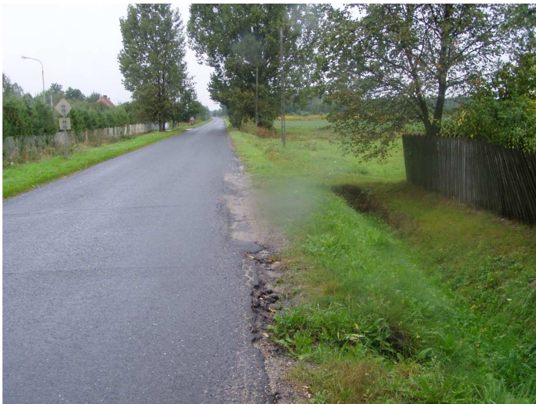
pas drogowy drogi powiatowej nr 1470 D km 2+500 str. P miejsowość Drogoszowice
