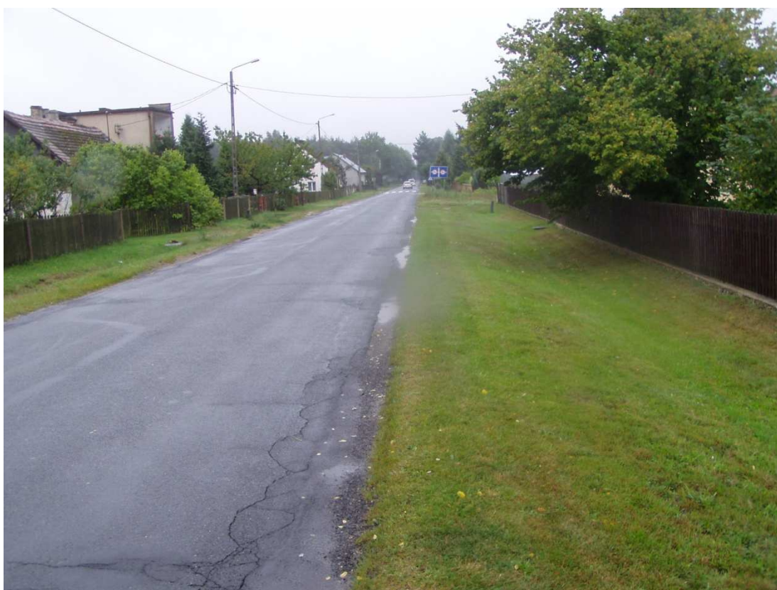
pas drogowy drogi powiatowej nr 1470 D km 0+350 miejscowość Sosnówka – strona L
