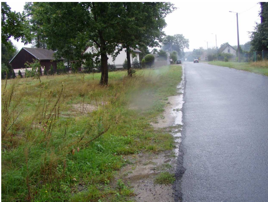
pas drogowy drogi powiatowej nr 1470 D km 2+000 miejsowość Drogoszowice – strona L
