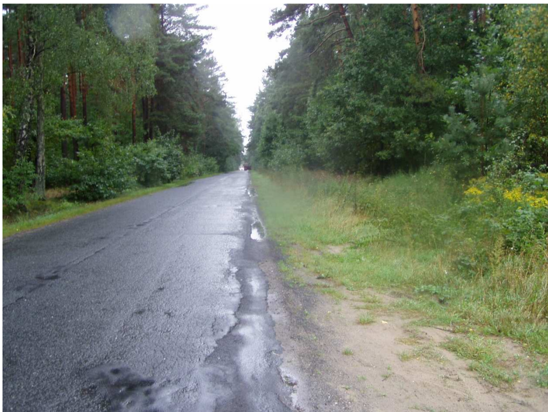
pas drogowy drogi powiatowej nr 1470 D km 1+350 teren niezabudowany – strona L
