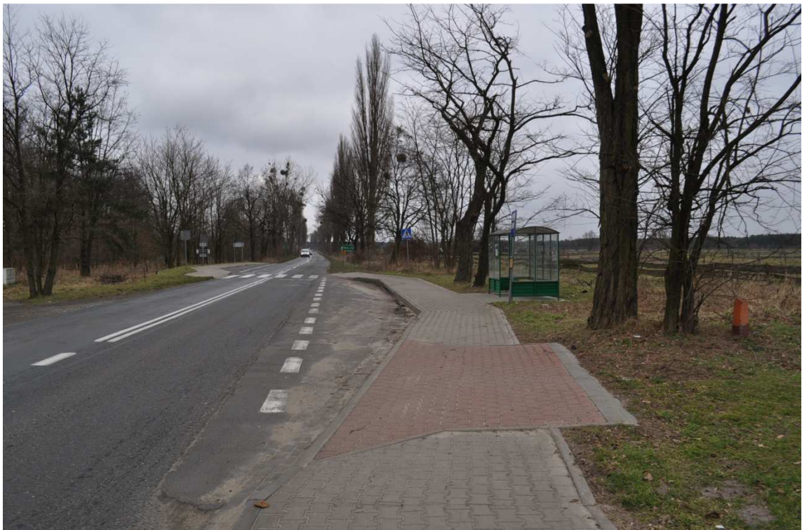
Stan istniejący pasa drogowego drogi wojewódzkiej Nr 448
