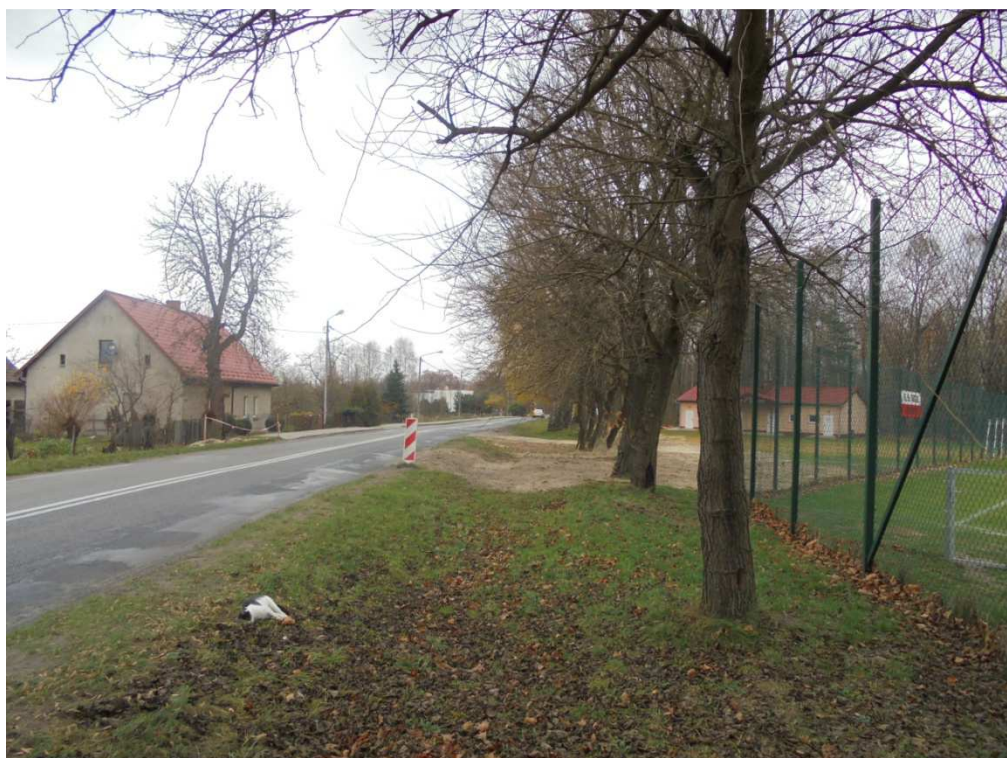
Stan istniejący pasa drogi wojewódzkiej Nr 448 pod projektowany ciąg pieszo-rowerowy
