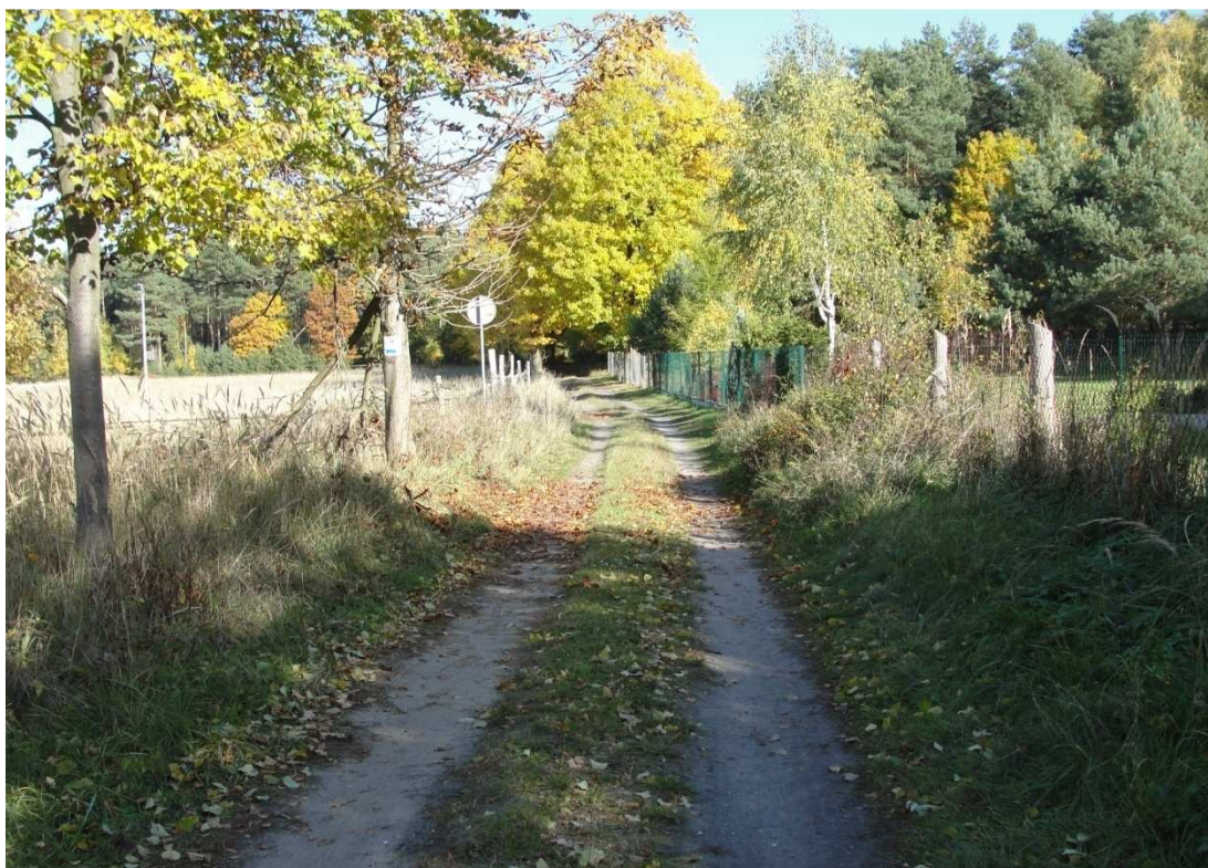
Stan istniejący nawierzchni drogi wewnętrznej Koniec Zakresu Opracowania
