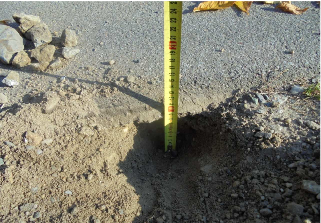
4cm nawierzchnia bitumiczna, 11cm tłućzeń kamienny
