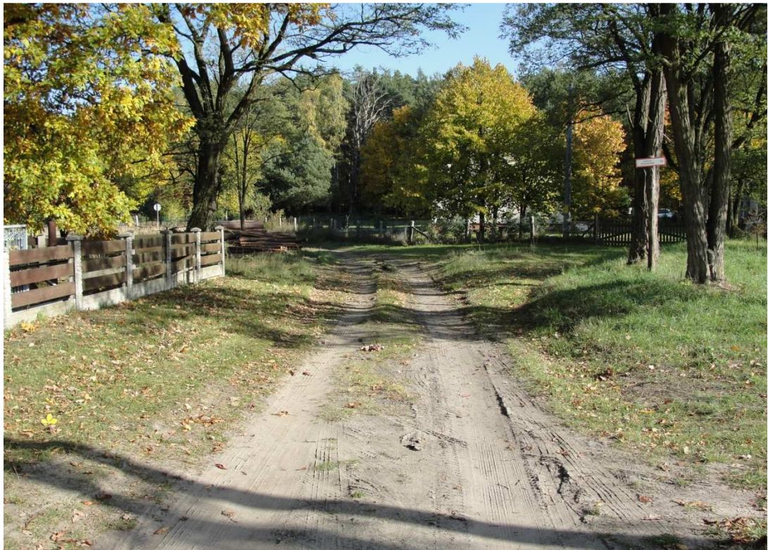
Stan istniejący nawierzchni drogi wewnętrznej
