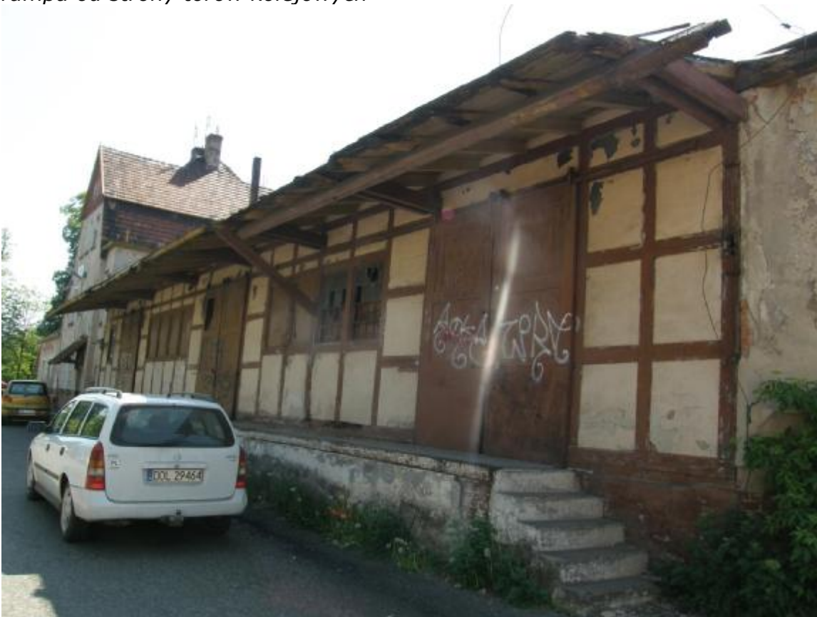
rampa od strony północnej
