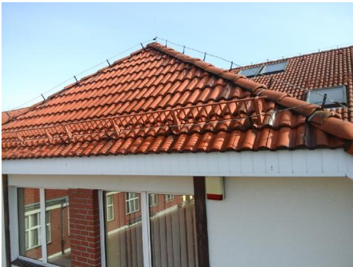
Brak rynny –dach nad wejściem
