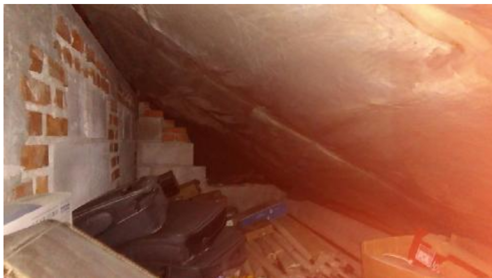
Wnętrze przestrzeni technicznej za ścianą kolankową
