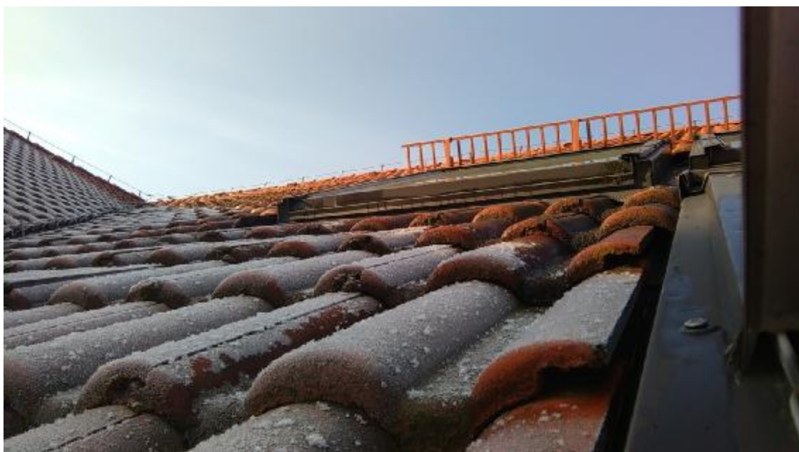
Brak rynny –dach nad wejściem
