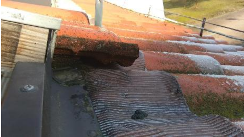
Taśmy przy oknach połaciowych
