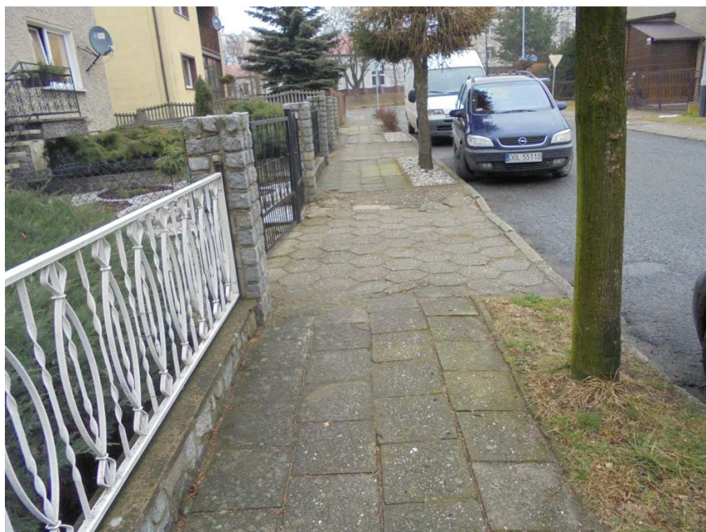
Stan istniejący chodnika ul. Kołtątaja
