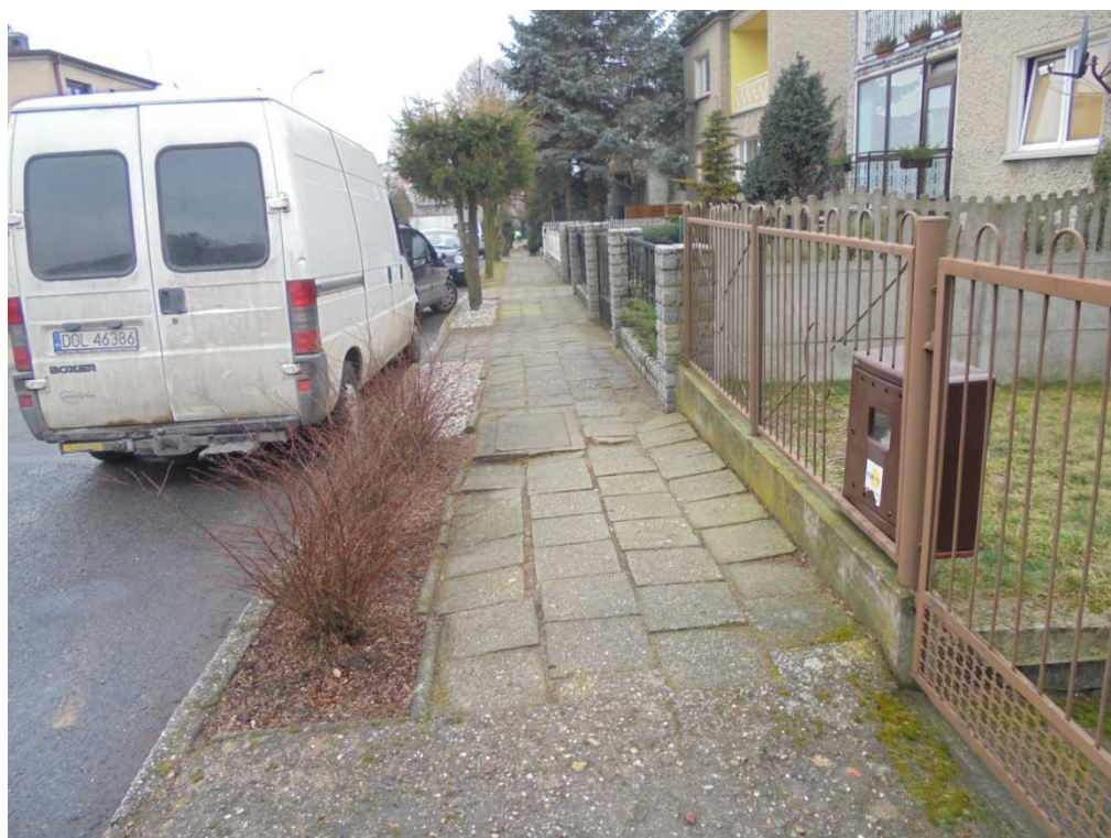
Stan istniejący chodnika ul. Kołtątaja
