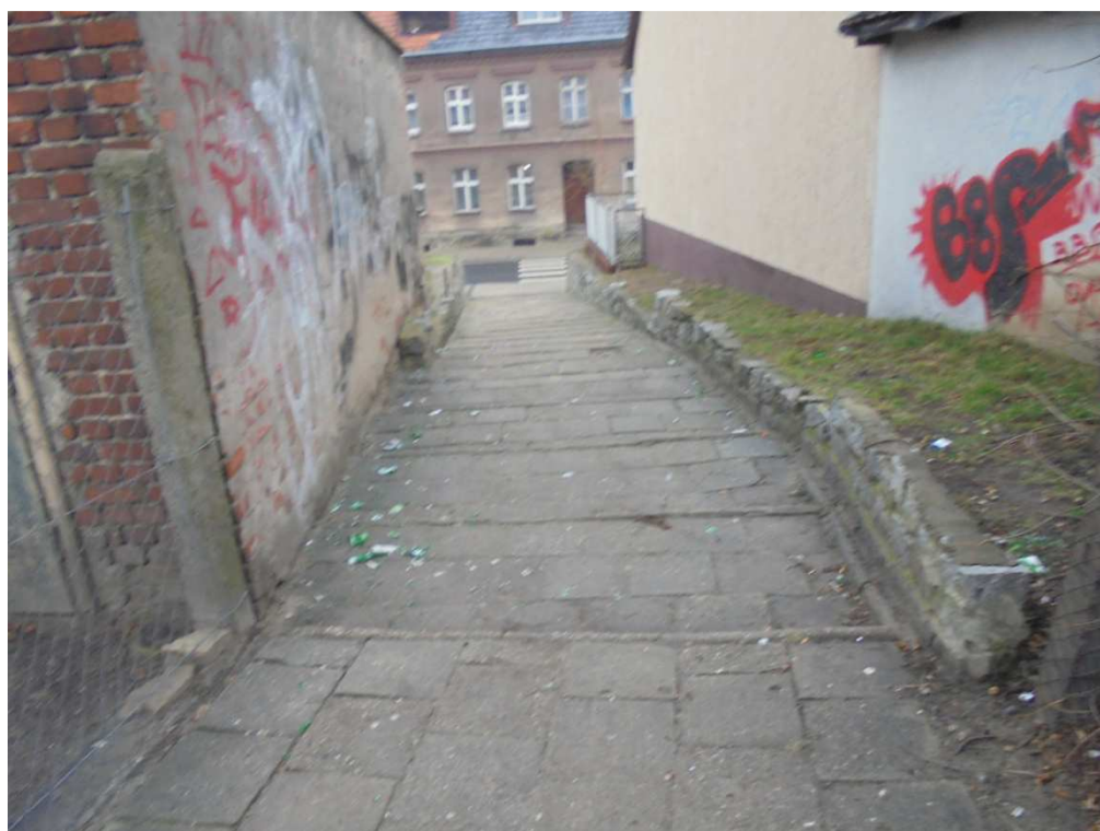
Stan istniejący chodnika łącznik pomiędzy ul. Szkolną a ul. Długą
