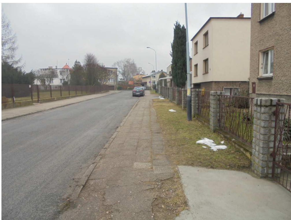
Stan istniejący chodnika ul. Staszica
