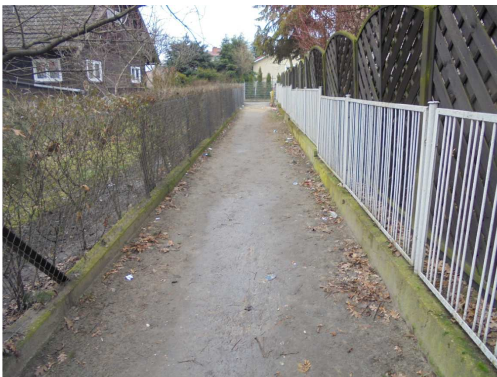
Stan istniejący nawierzchni łącznika pomiędzy ul. Szkolną a ul. Grunwaldzką
