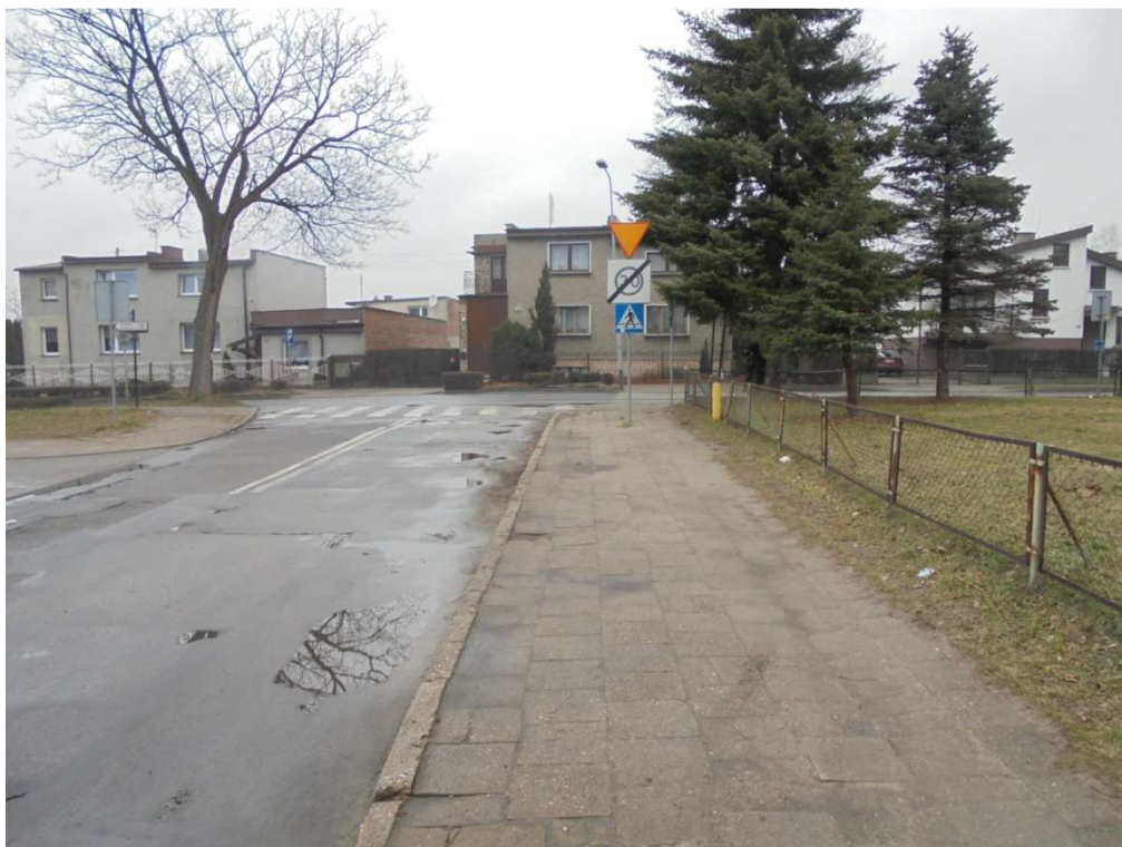
Stan istniejący chodnika ul. Staszica
