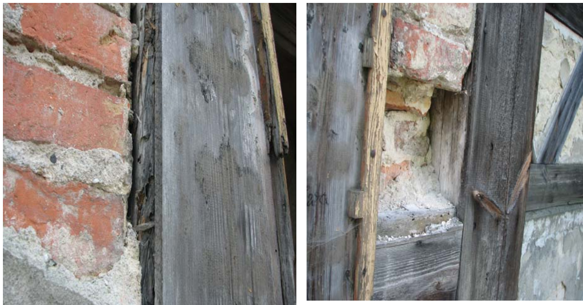
Zdjęcie Nr 7 i Nr 8 – widoczne szpary pomiędzy konstrukcją drewnianą a ceglany wypełnieniem.
