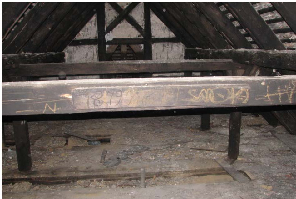
Zdjecie Nr 2 – wieżba dachowa.
