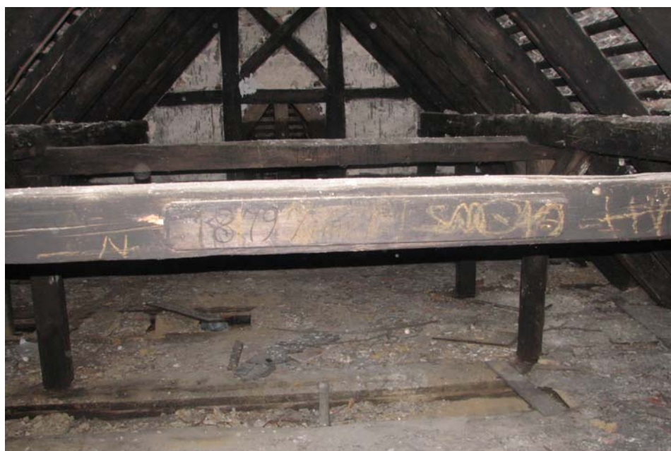
Zdjecie Nr 2 – więźba dachowa.
