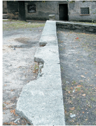
ISTN. MUR z formaków granitowych
