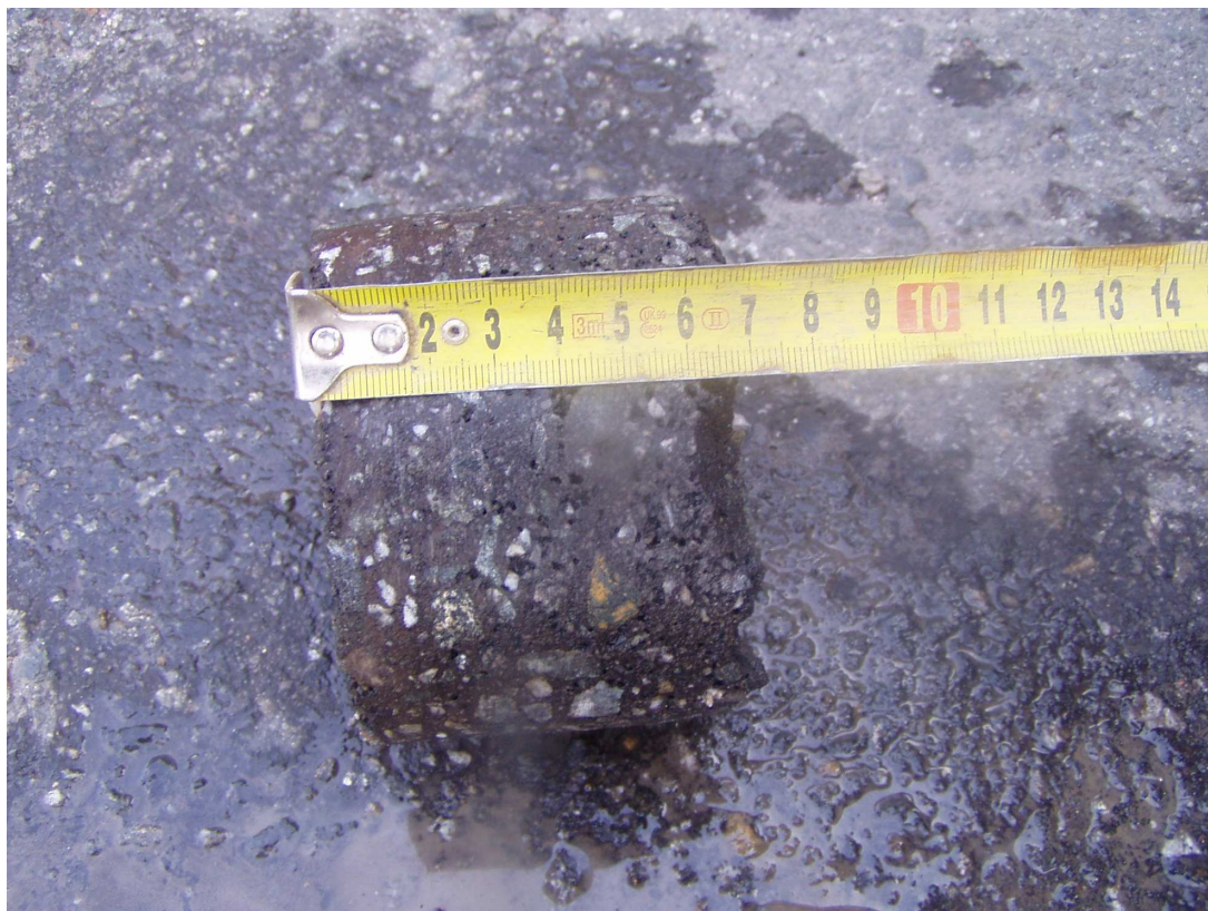
Wykonywanie odwiertów w istniejącej nawierzchni drogi km 0+193, nawierzchnia bitumiczna gr. 7cm
