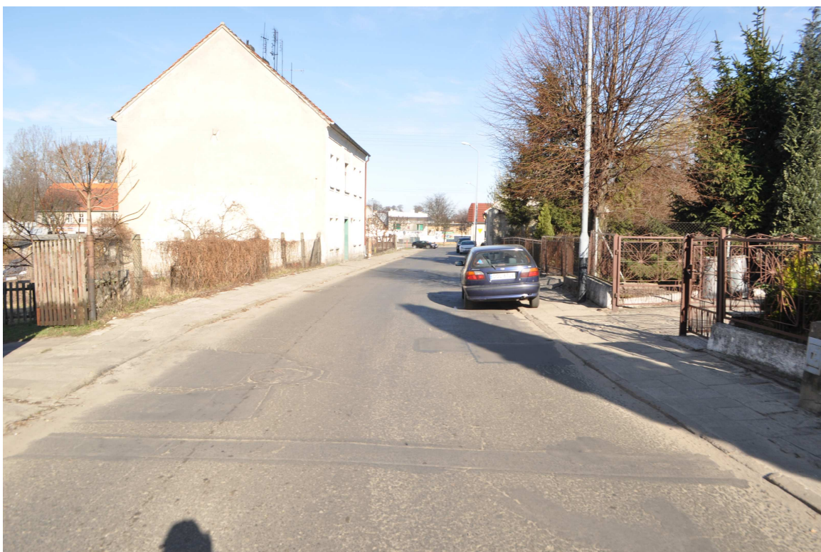
Droga gminna ul. Długa km 0+090 - stan techniczny nawierzchni widok w kierunku skrzyżowania z drogą wojewódzką nr 448
