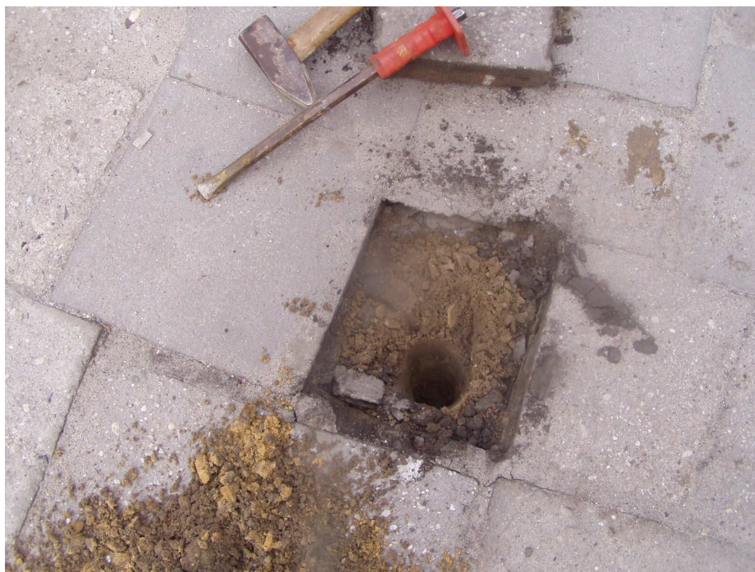
Odwiert ręczny nr 3 w chodniku strona prawa płytką chodnikową gr. 6cm, piasek gr. 25cm
