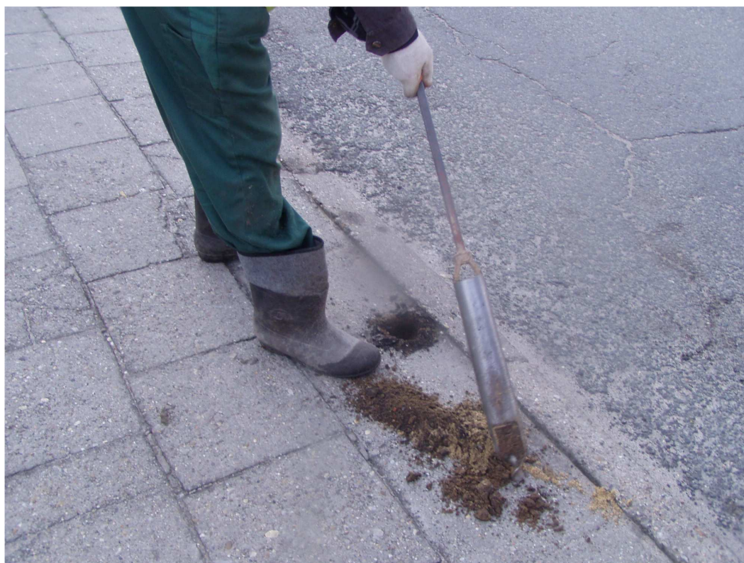
Odwiert ręczny nr 7 w chodniku strona lewa km 0+028
