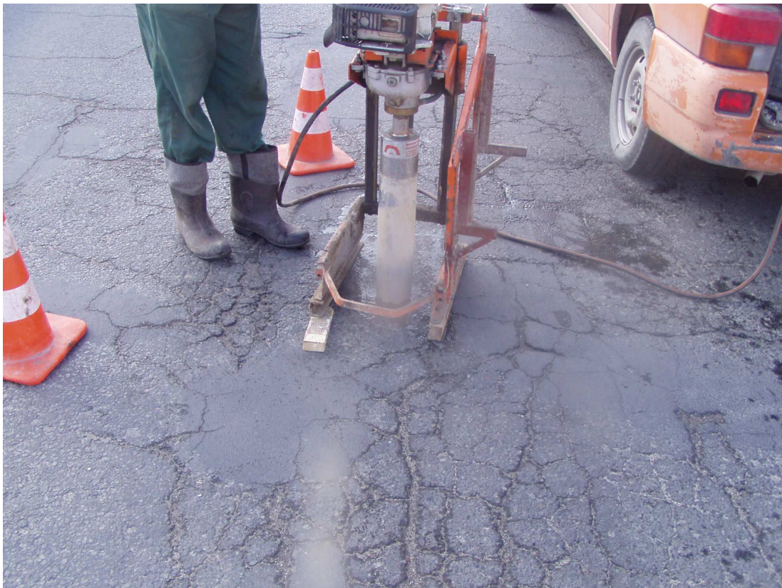
Wykonywanie odwiertów w istniejącej nawierzchni drogi Odwiert nr 1 km 0+020
