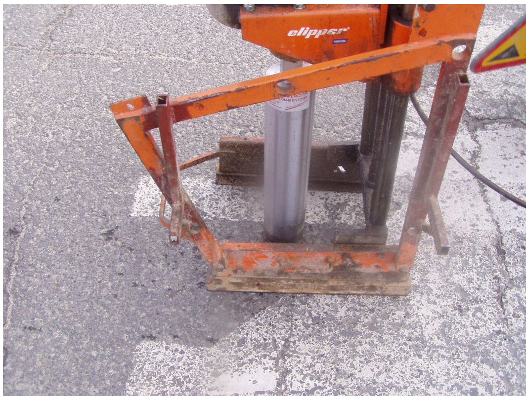
Wykonywanie odwiertów w istniejącej nawierzchni drogi Odwiert nr 4 km 0+255
