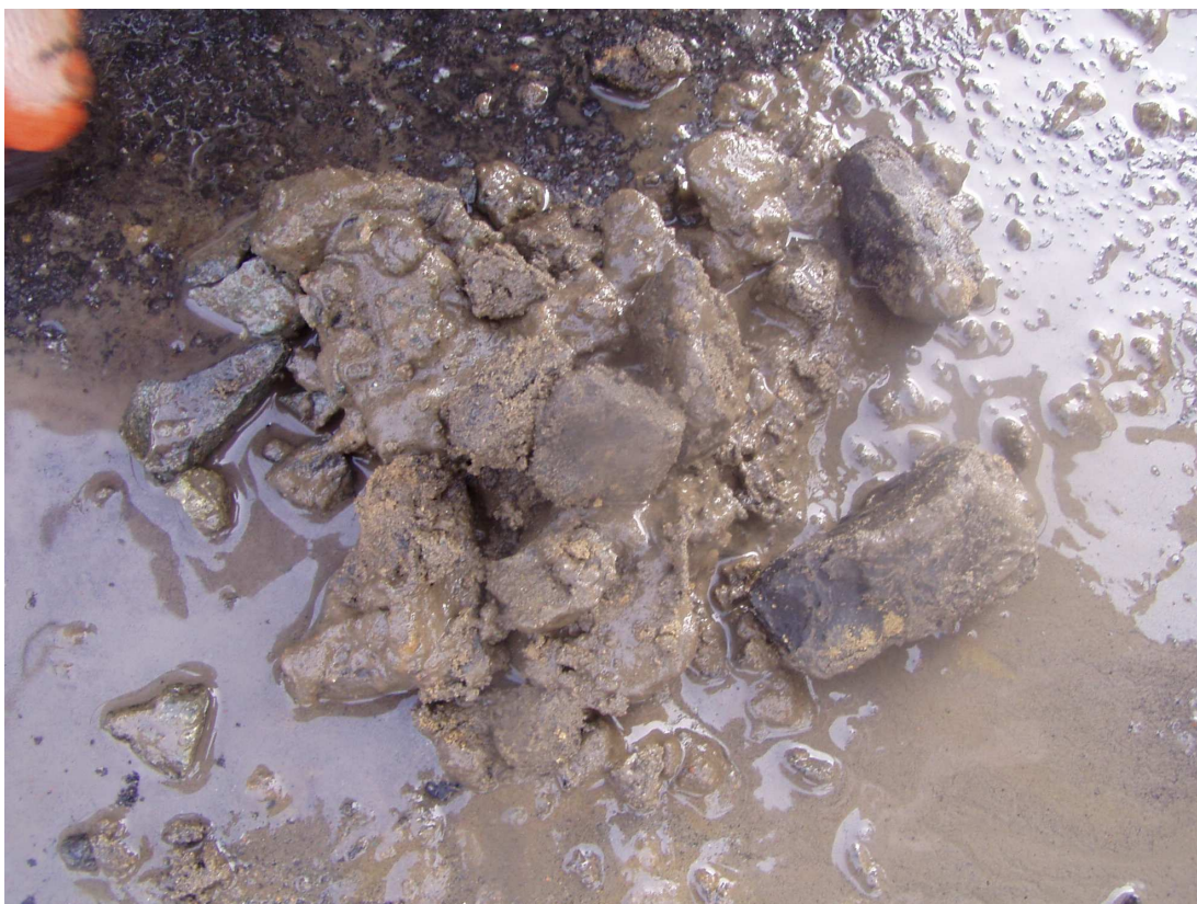
Wykonywanie odwiertów w istniejącej nawierzchni drogi km 0+255, podbudowa z tłucznią gr. 17cm + podbudowa kamienna
