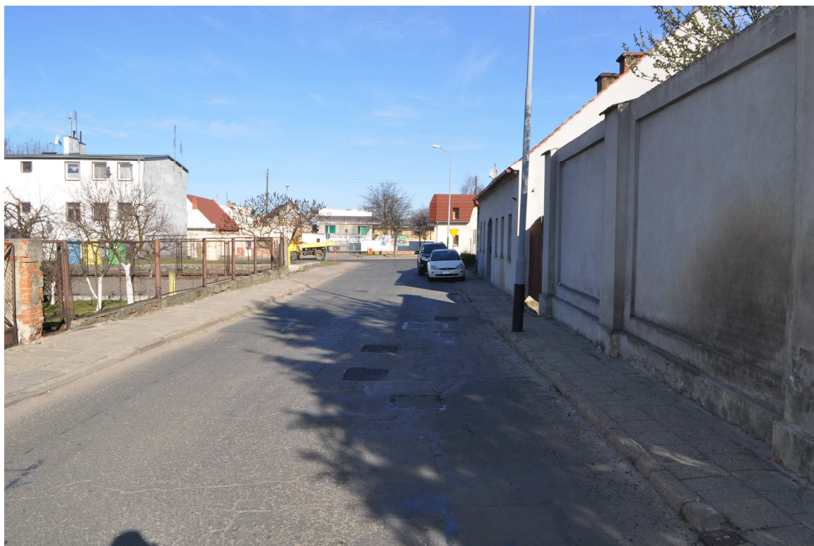
Droga gminna ul. Długa km 0+050 - stan techniczny nawierzchni
