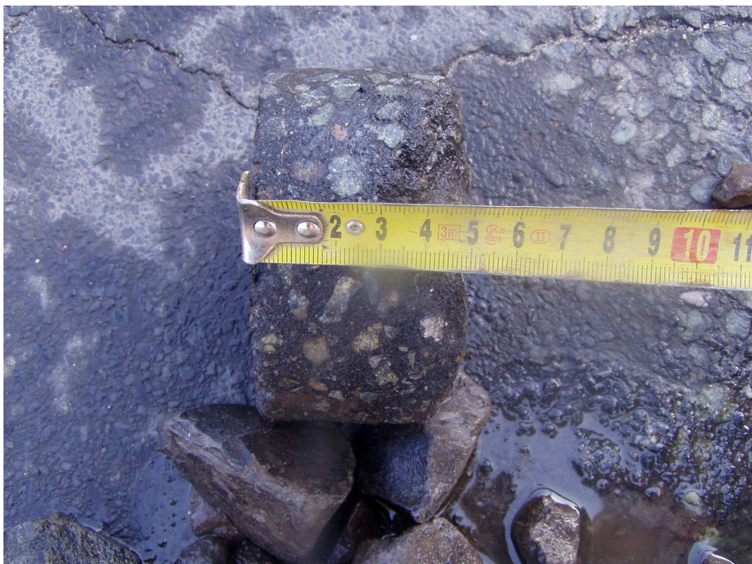
Wykonywanie odwiertów w istniejącej nawierzchni drogi km 0+020, nawierzchnia bitumiczna gr. 5cm
