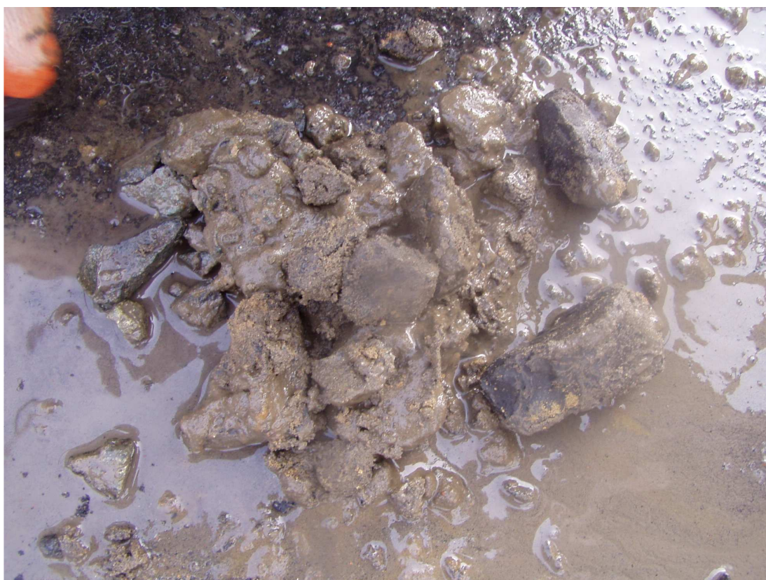
Wykonywanie odwiertów w istniejącej nawierzchni drogi km 0+193, podbudowa z łucznią gr. 15cm + podbudowa kamienna
