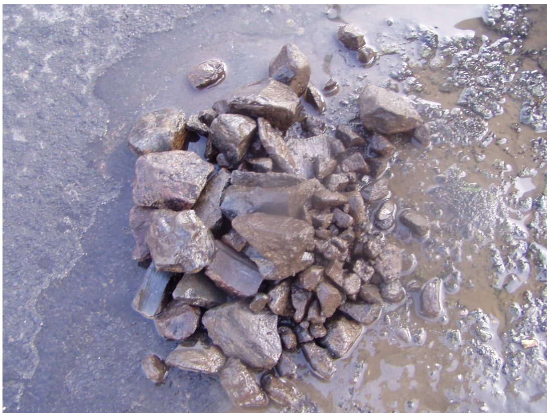
Wykonywanie odwiertów w istniejącej nawierzchni drogi km 0+020, podbudowa z tłuczni kamiennego gr. 15cm
