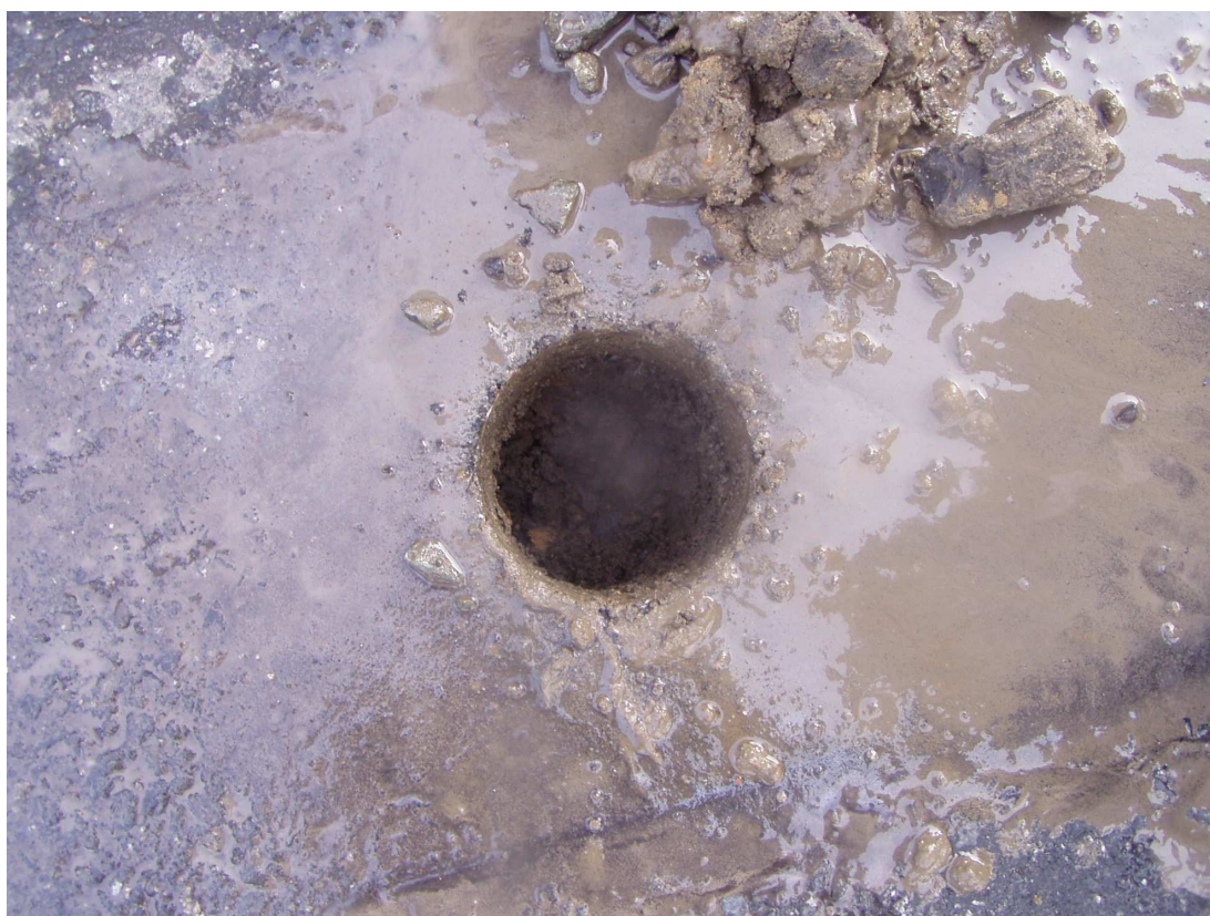
Wykonywanie odwiertów w istniejącej nawierzchni drogi Odwiert nr 2 km 0+193
