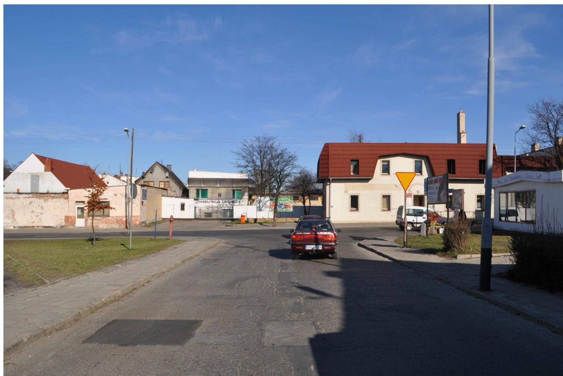
Droga gminna ul. Długa - stan techniczny nawierzchni Widok od strony ul. Długiej w kierunku drogi wojewódzkiej nr 448
