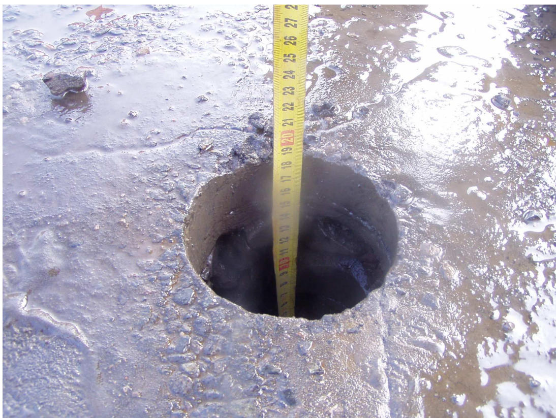
Wykonywanie odwiertów w istniejącej nawierzchni drogi Odwiert do głębokości 250cm p.p.t.
