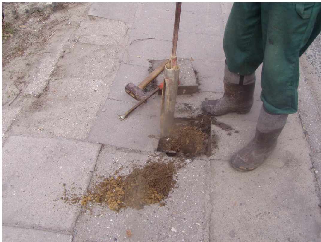
Odwiert ręczny nr 3 w chodniku strona prawa km 0+193
