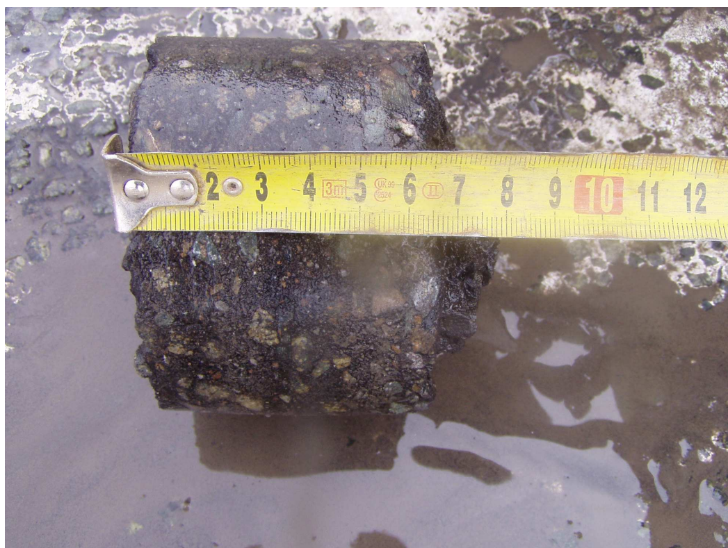
Wykonywanie odwiertów w istniejącej nawierzchni drogi km 0+255, nawierzchnia bitumiczna gr. 7cm
