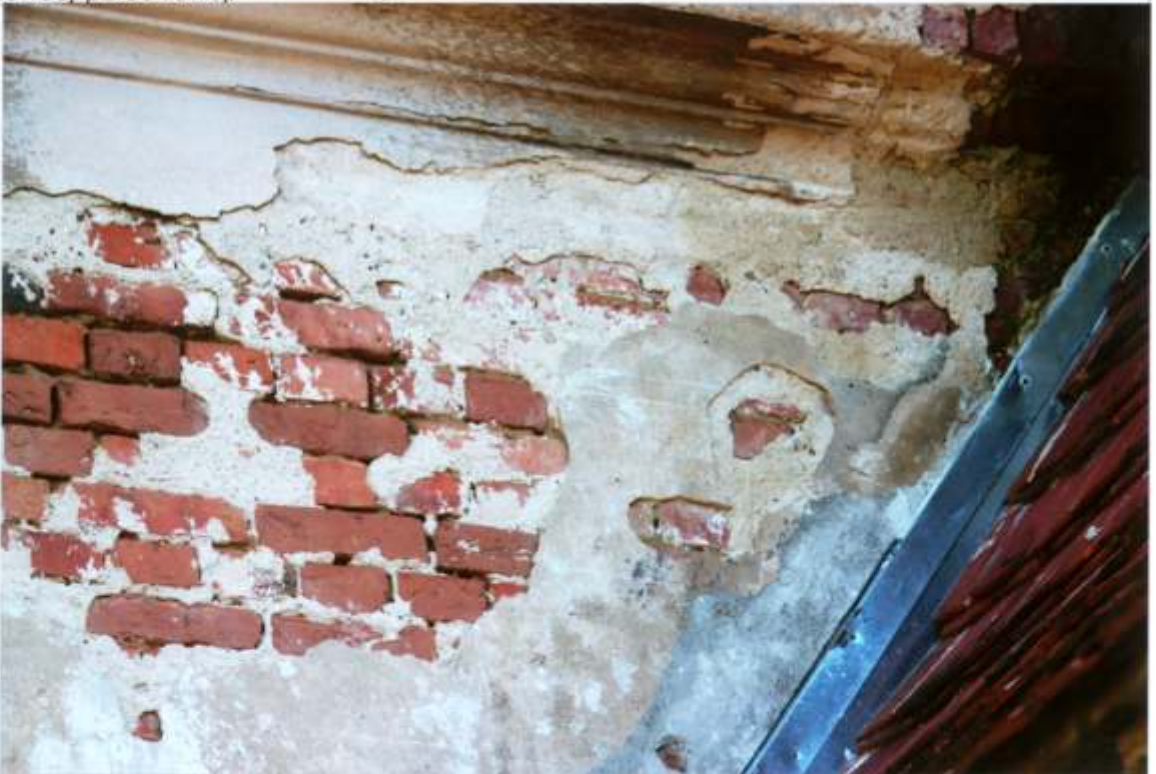
FOT. 40 - Goszcz, zespół pałacowy, skrzydło południowo - wschodnie, dom gościnny, elewacja południowa, fragment. Widoczne ryty w tynku i fazy chronologicznej - poziome kreski (rysowane bonie pseudopilastrów ?).
