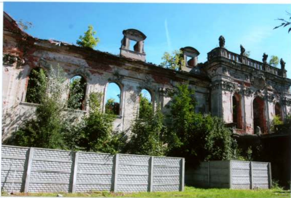
FOT. 46 - Goszcz, zespół pałacowy, Pałac, elewacja południowa, fragment, widok ogólnym
