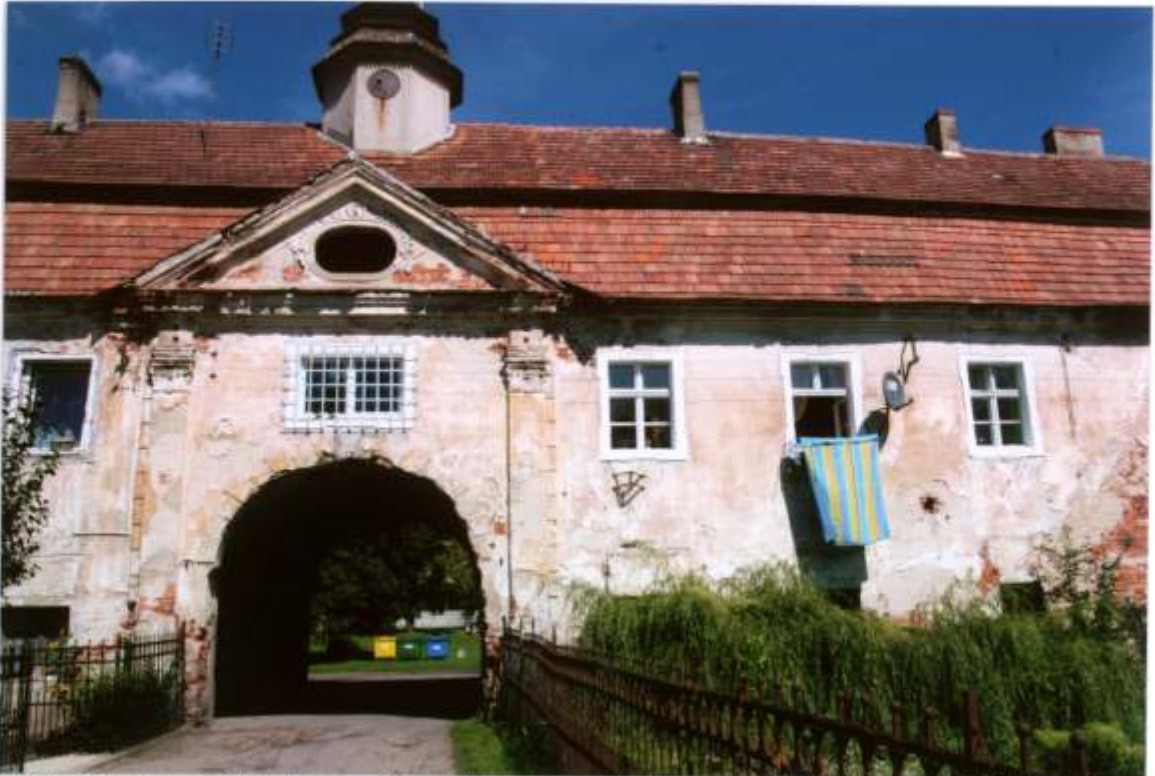
FOT. 51 - Goszcz, zespół pałacowy, Budynek bramny, elewacja południowa, fragment, widok ogólny.
