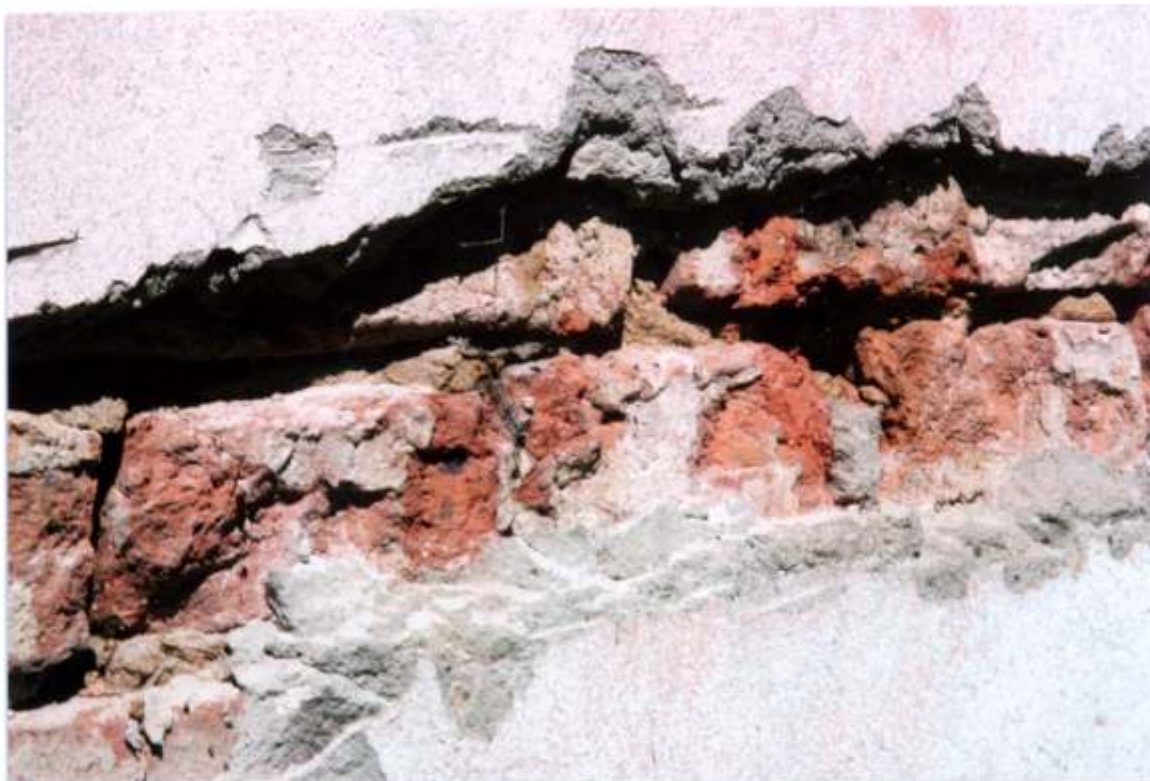
FOT. 3 - Goszcz, zespół pałacowy, skrzydło północno – zachodnie. Maneż, elewacja południowo – wschodnia, odkrywka.
