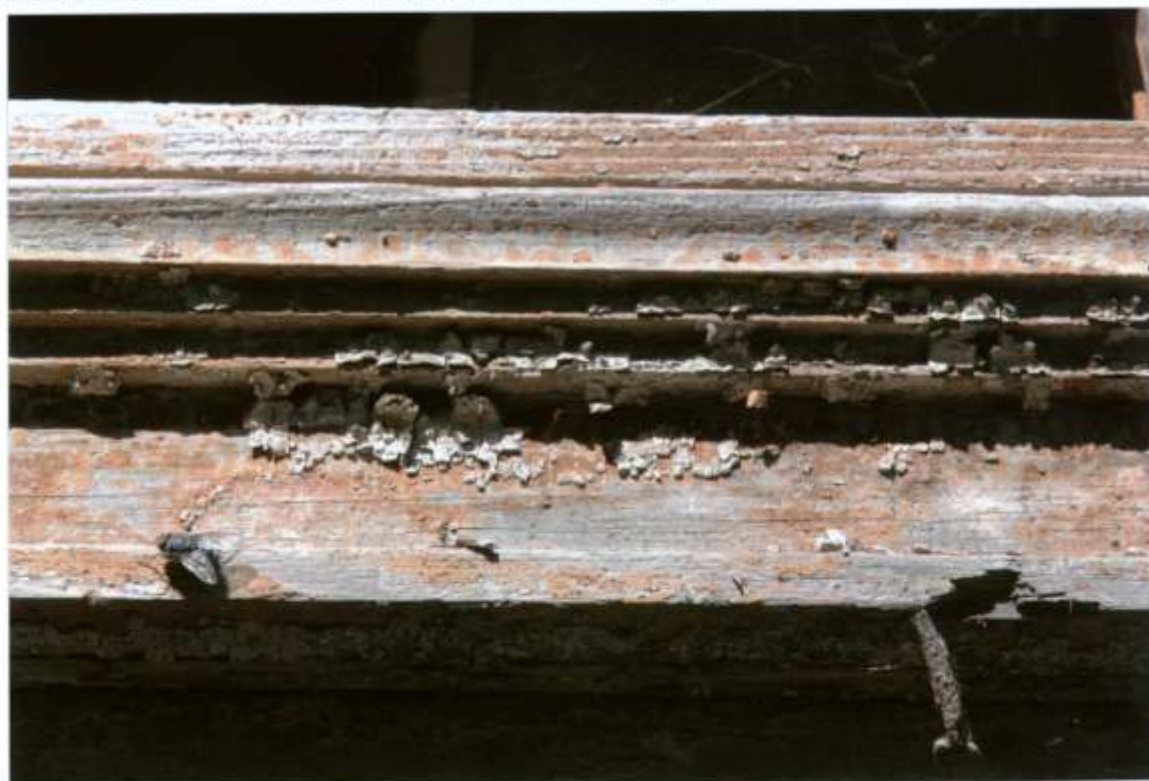
FOT. 24 - Goszcz, zespół pałacowy, skrzydło północno – zachodnie. Stajnia koni wyjazdowych, elewacja południowo – wschodnia, okno, detal fot. 23
