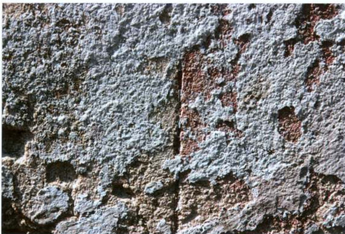
FOT. 13, 14 - Goszcz, zespół pałacowy, skrzydło północno – zachodnie. Stajnia koni wyjazdowych, elewacja południowo – wschodnia, detal fot. 10.
