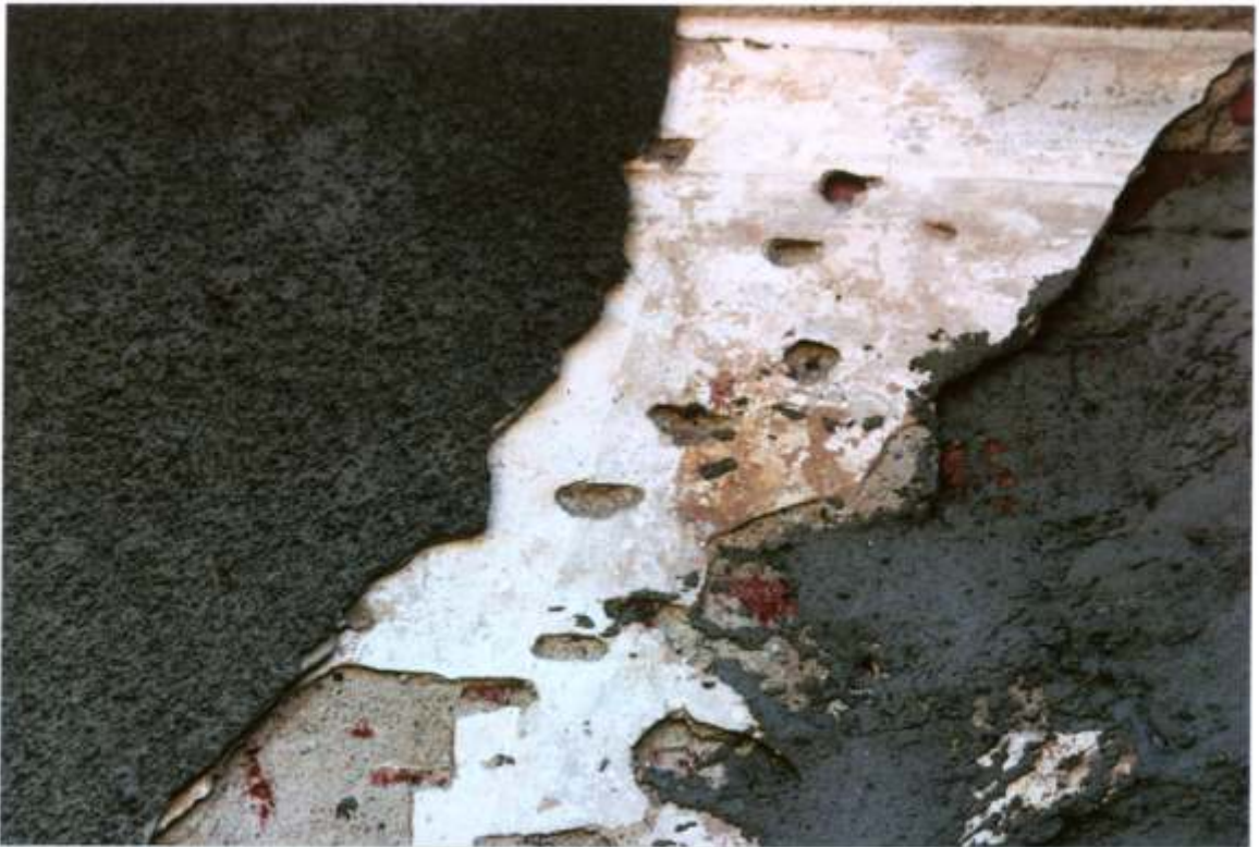
FOT. 37 - Goszcz, zespół pałacowy, skrzydło południowo - wschodnie, dom oficjalistów, Malowany klin nad oknem - I faza chronologiczna.
