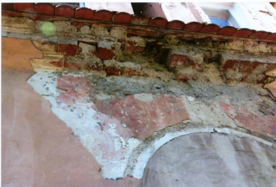
FOT. 12 - Goszcz, zespół pałacowy, skrzydło północno – zachodnie. Stajnia koni wyjazdowych, elewacja południowo – wschodnia. Odkrywka nad oknem I osi od północy. Widoczne warstwy malarskiej I fazy chronologicznej, biały pion z lewej strony na czerwonym tle. Relikty tynku po oprawie sztukatorskiej okna.
