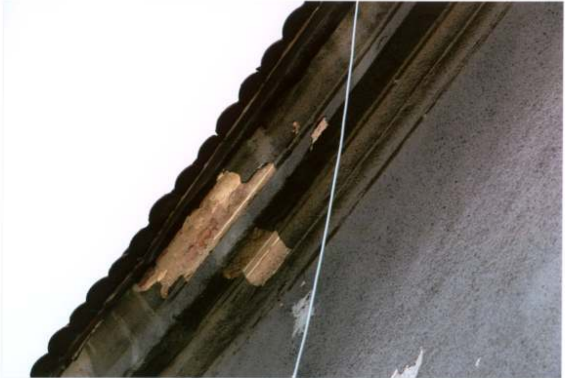
FOT. 29 - Gószcz, zespół pałacowy, skrzydło południowo – wschodnie, oficyna, fragment, Gzyms koronujący.
