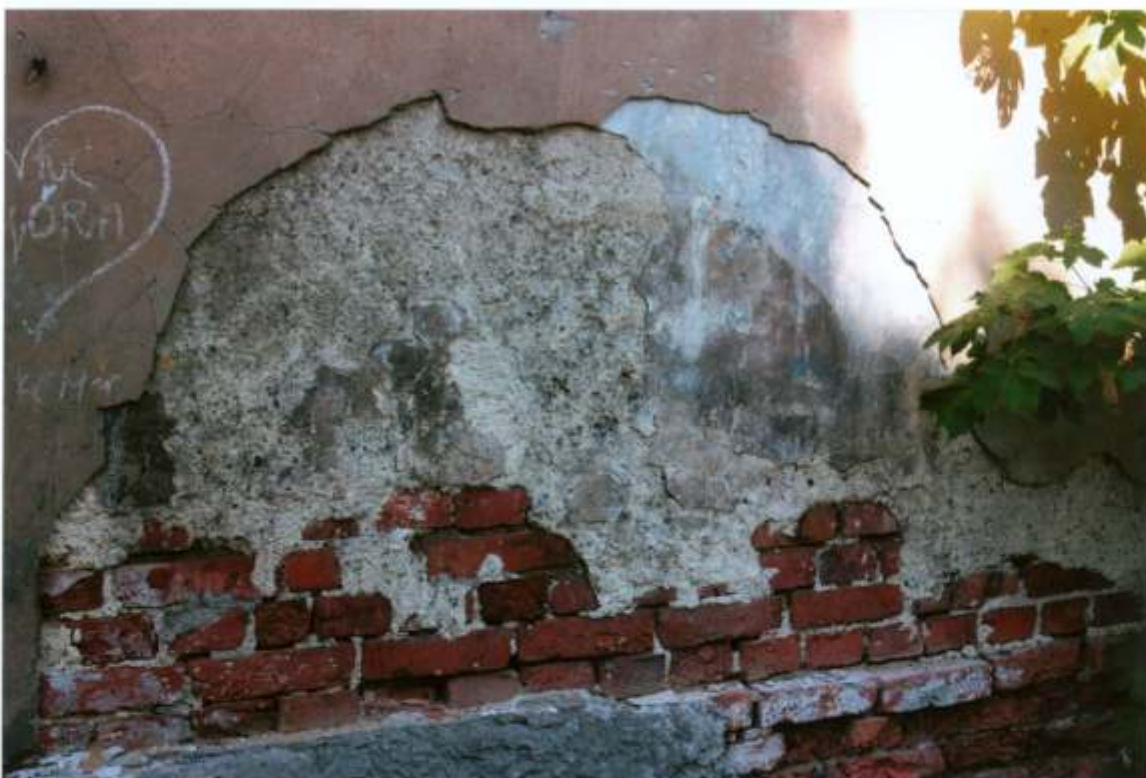
FOT. 20 - Goszcz, zespół pałacowy, skrzydło północno – zachodnie. Stajnia koni wyjazdowych, elewacja południowo – wschodnia, detal fot. 19.
