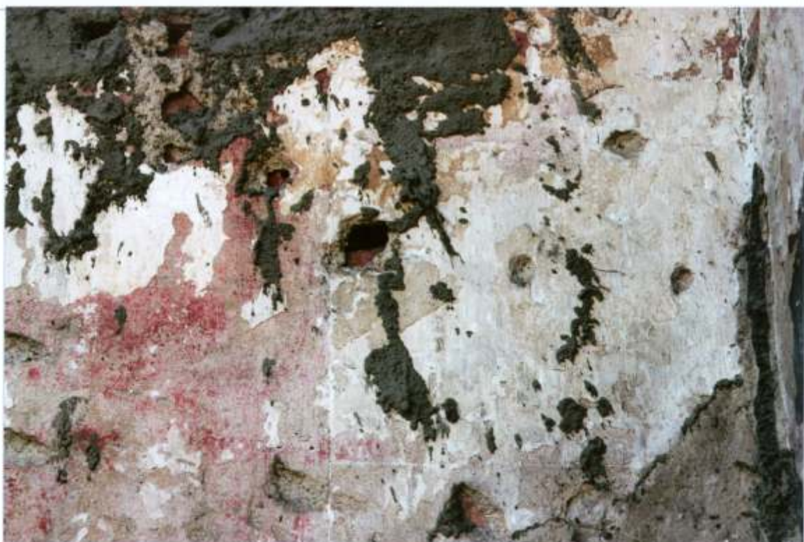
FOT. 35, 36 - Goszcz, zespół pałacowy, skrzydło południowo - wschodnie, dom oficjalistów, fragment. Tynki pierwotne z czerwoną kolorystyką i rytem w tynku.
