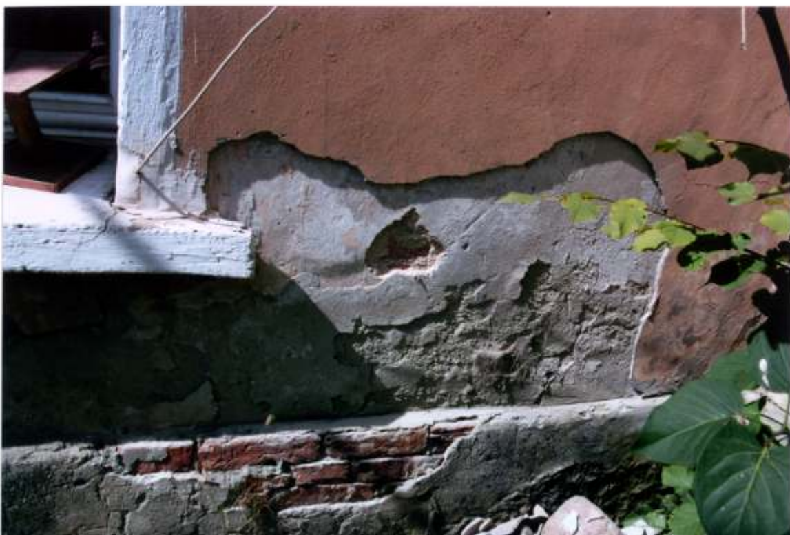
FOT. 7 - Goszcz, zespół pałacowy, skrzydło północno – zachodnie. Stajnia koni wyjazdowych, elewacja południowo – wschodnia, odkrywka przy oknie I osi od północy.
