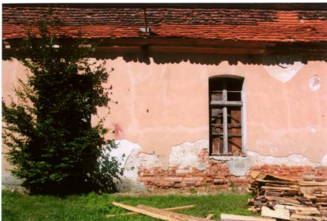
FOT. 17 - Goszcz, zespół pałacowy, skrzydło północno – zachodnie. Stajnia koni wyjazdowych, elewacja południowo – wschodnia, fragment. Okno IV osi od północy. W prawym, górnym narożniku kadru odkrywka z widocznym łukiem muru.
