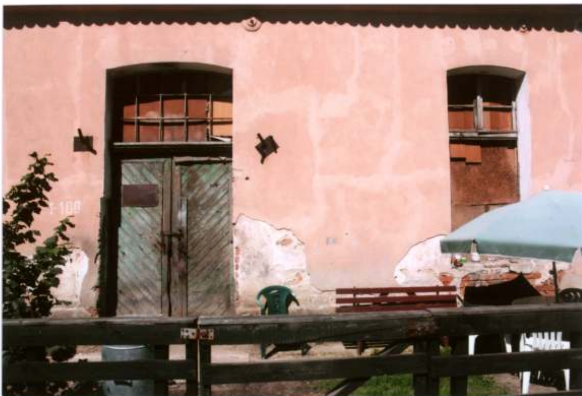
FOT. 15 - Goszcz, zespół pałacowy, skrzydło północno - zachodnie. Stajnia koni wyjazdowych, elewacja południowo - wschodnia, fragment. Drzwi III osi od północy.
