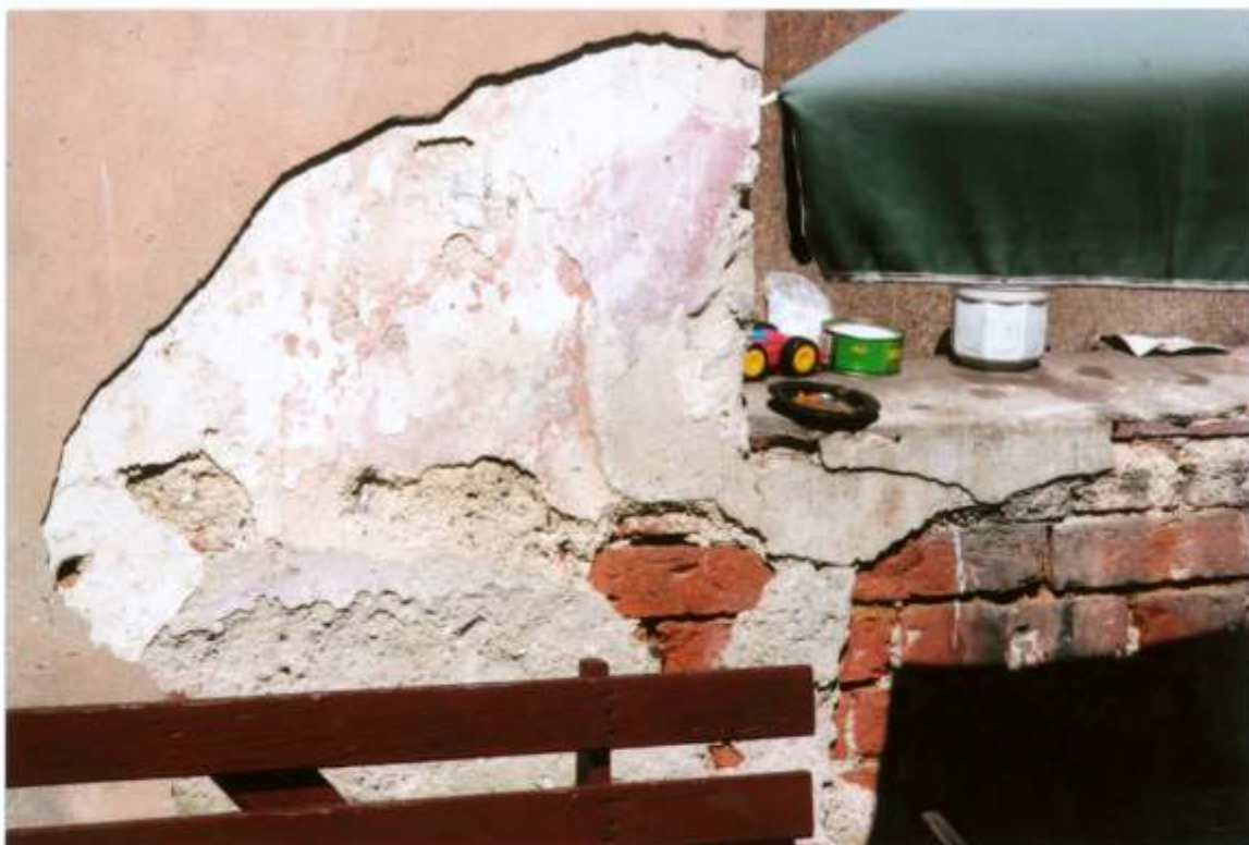
FOT. 16 - Goszcz, zespół pałacowy, skrzydło północno - zachodnie. Stajnia koni wyjazdowych, elewacja południowo - wschodnia, detal fot. 15. Odkrywka przy oknie II osi od północy.
