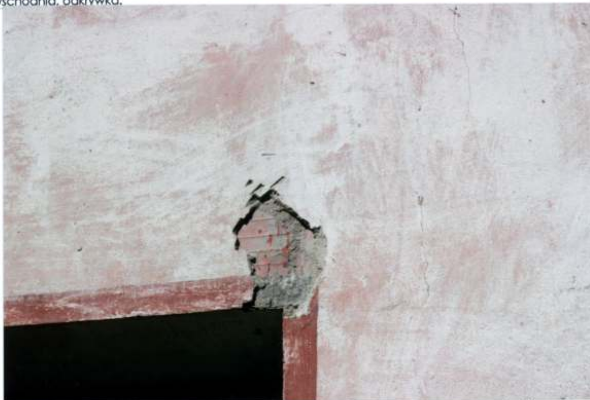
FOT. 4 - Goszcz, zespół pałacowy, skrzydło północno – zachodnie. Maneż, elewacja południowo – wschodnia, fragment.
