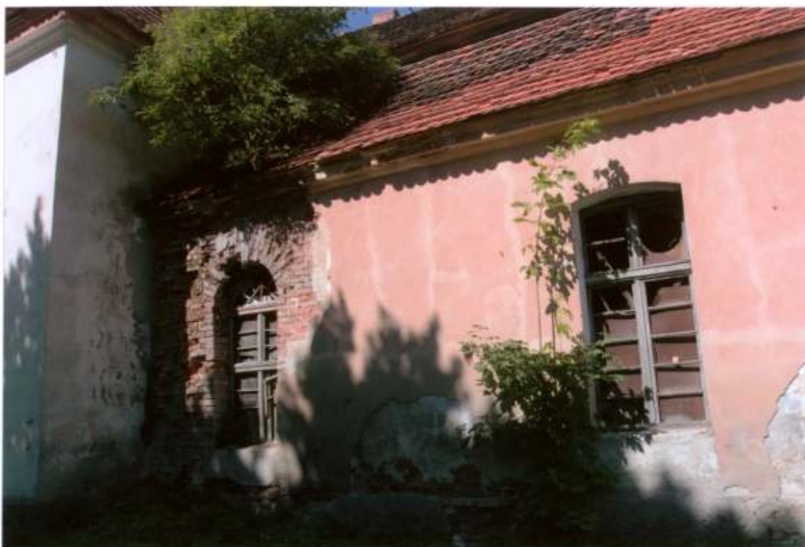
FOT. 19 - Goszcz, zespół pałacowy, skrzydło północno – zachodnie. Stajnia koni wyjazdowych, elewacja południowo – wschodnia, fragment, część południowa budynku.
