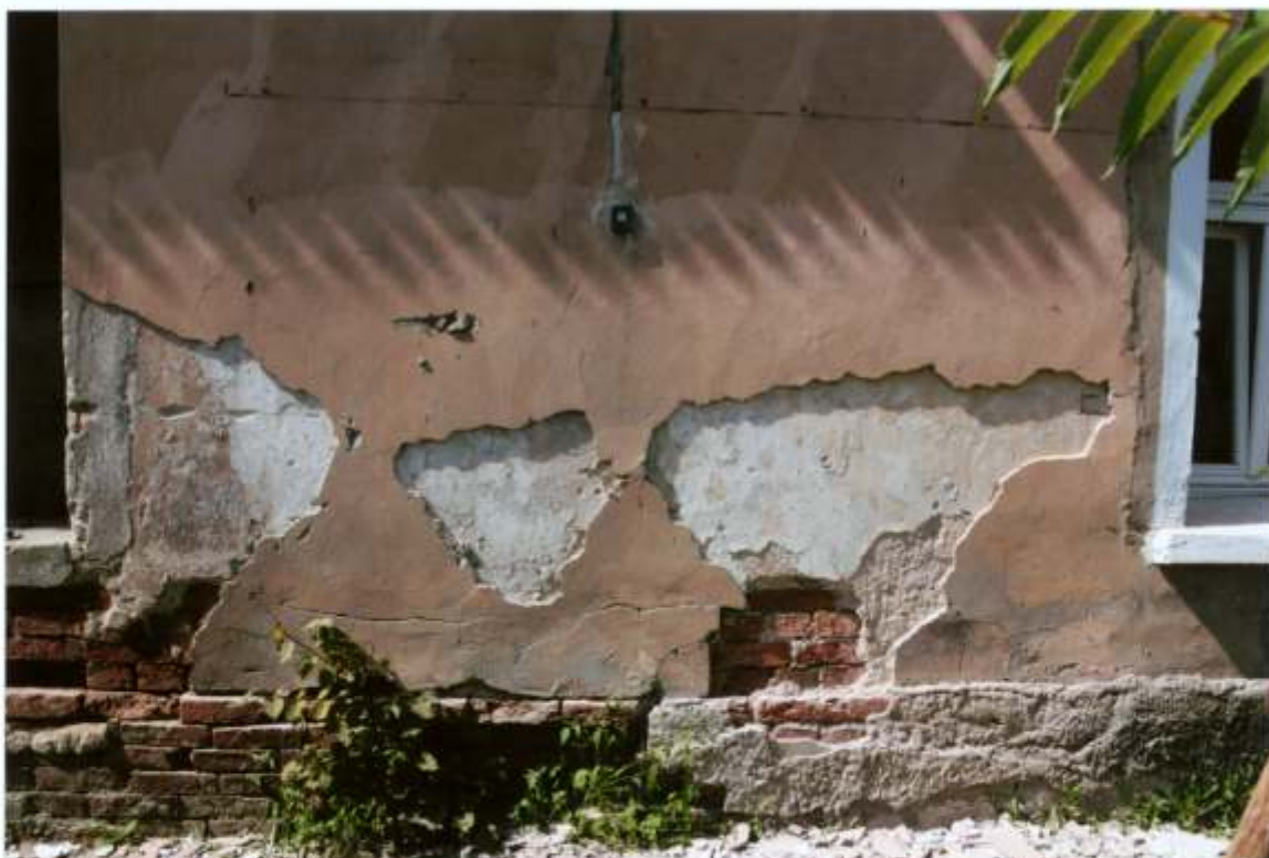
FOT. 10 - Goszcz, zespół pałacowy, skrzydło północno – zachodnie. Stajnia koni wyjazdowych, elewacja południowo – wschodnia. Odkrywka w płaszczyźnie tynku pomiędzy I i II osią elewacji od północy, widok ogólny.
