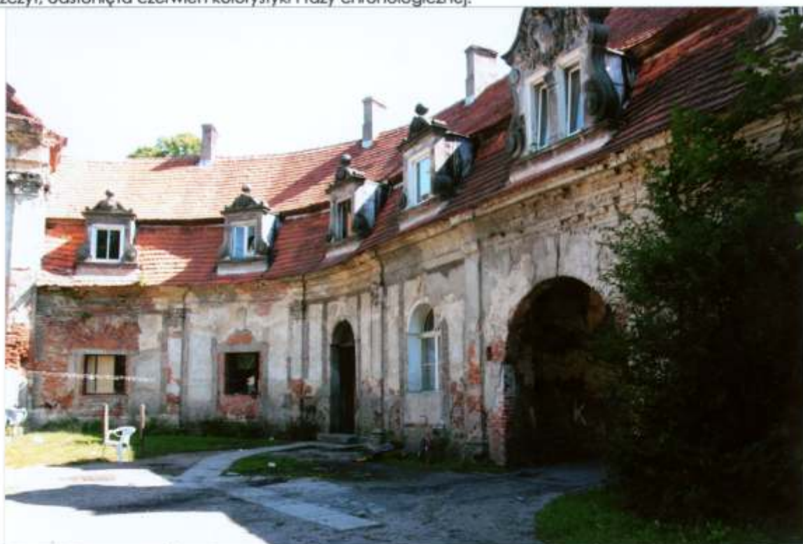
FOT. 44 - Goszcz, zespół pałacowy, skrzydło południowo – wschodnie, łącznik, widok ogólny.
