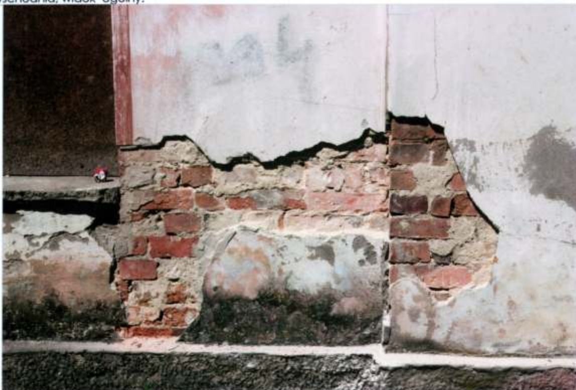
FOT. 2 - Goszcz, zespół pałacowy, skrzydło północno - zachodnie, Maneż, elewacja południowo - wschodnia, strefa cokołowa, odkrywka.
