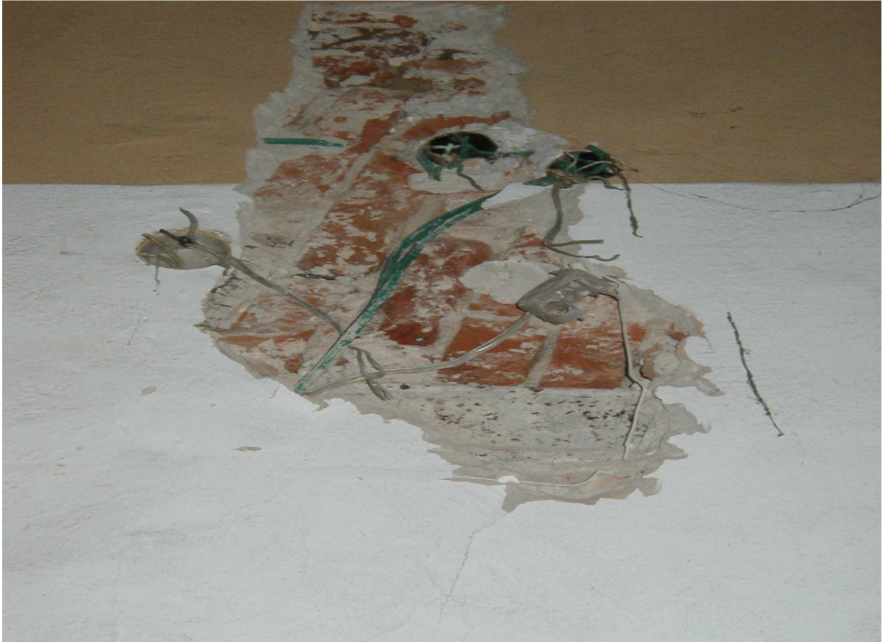
11.Przebudowane wejście główne od wewnątrz nadproże z szyny kolejowej max otwór h=320x500
