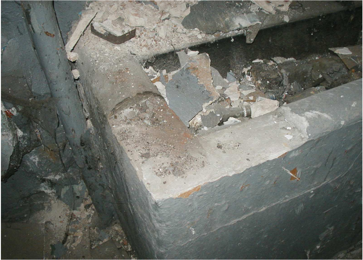
7. Poidła dla koni murowane z cegły w pomieszczeniu z sklepieniem krzyżowym z cegły.
