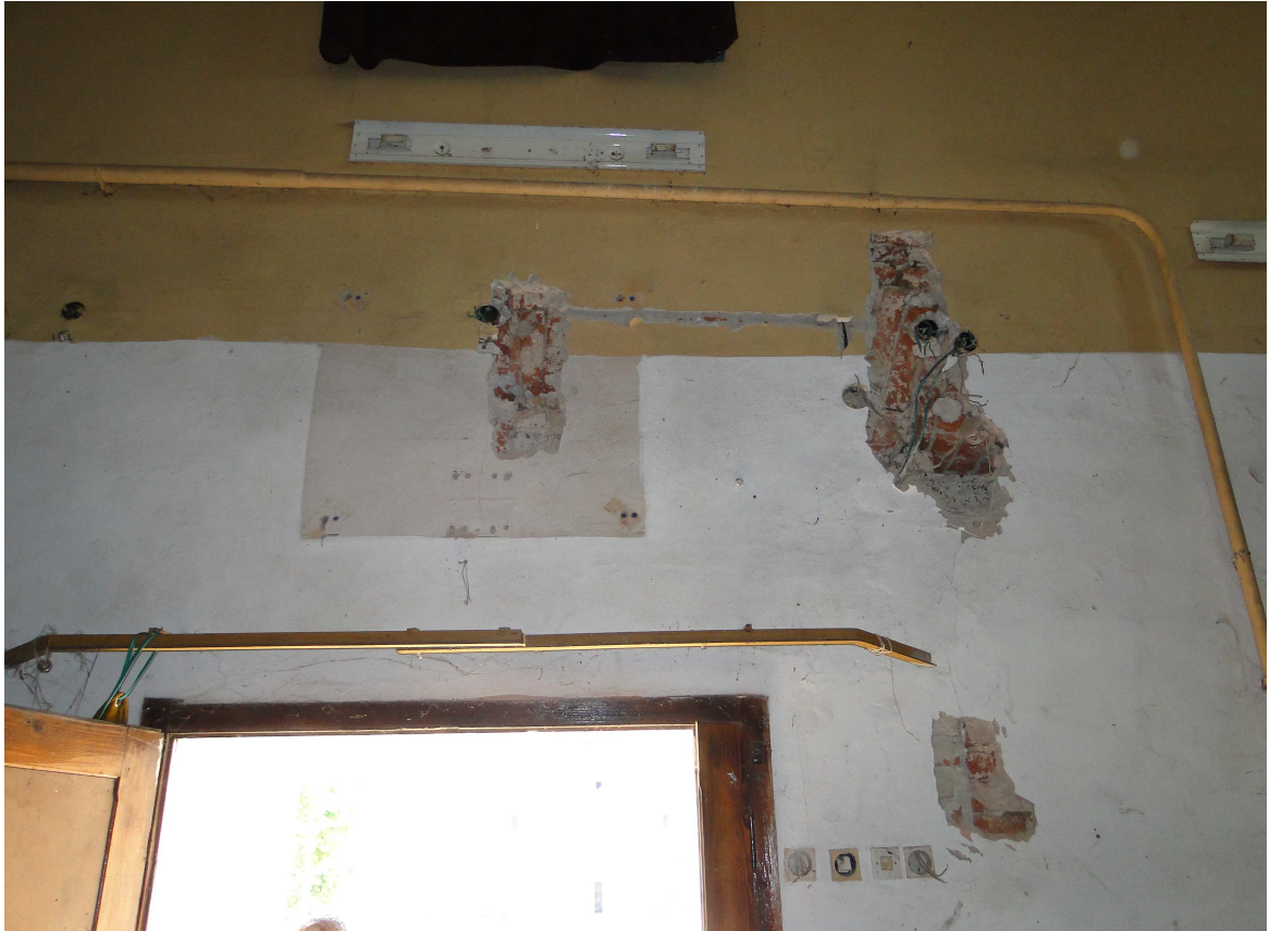
3. Odkrywka nad wejściem głównym do maneżu
