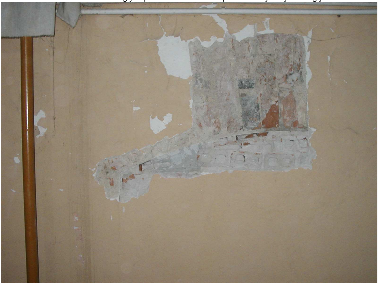
8. Zamurowany otwór łączący maneż ze stajnią o wym. max od poziomu 0 podłoga h=257 x s=148 cm
