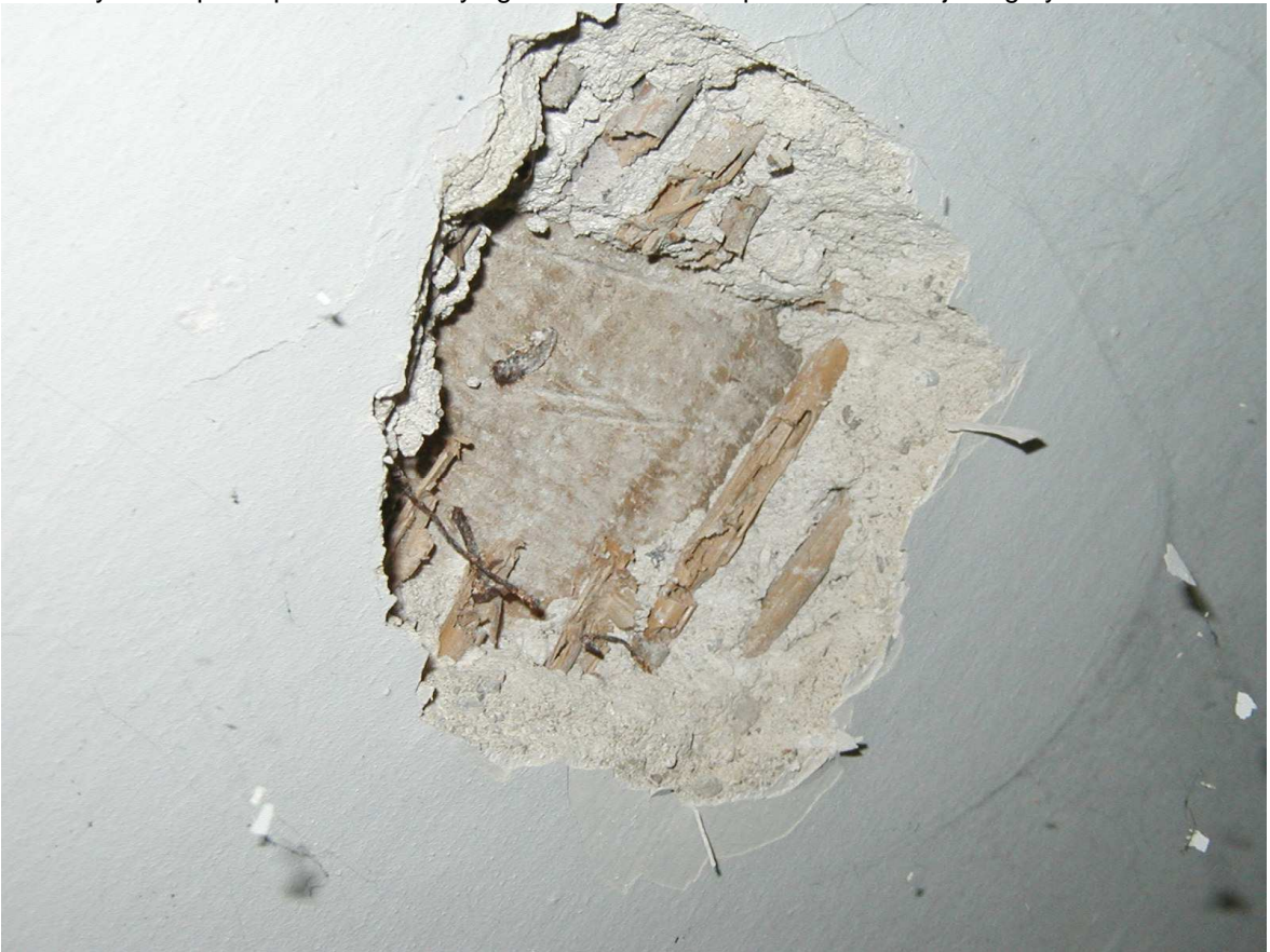
6. Odkrywka sufitu byłego wnętrza maneżu brak polichromii na desce stropu
