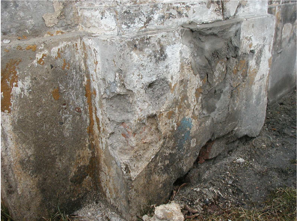
10. Odkrywka narożnika muru w przyziemiu pilaster w cegle brak izolacji pionowej i poziomej.
