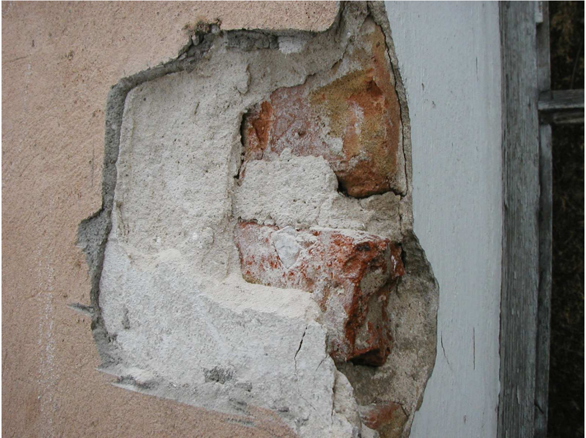
1. Odkrywka opaski okna budynku gospod. G tynk wapienny pokryty tynkiem cementowym
