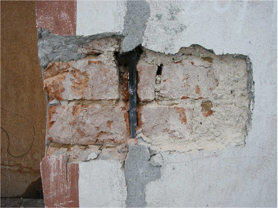
5. Odkrywka w pasie parteru okno byłego maneżu – brak opaski kamiennej i negatywu
