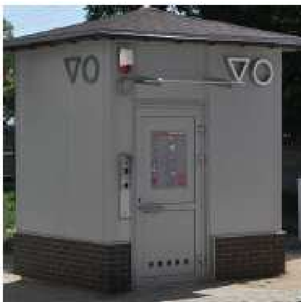
Sanitariat – kontenerowa toaleta publiczna (nr 1)
