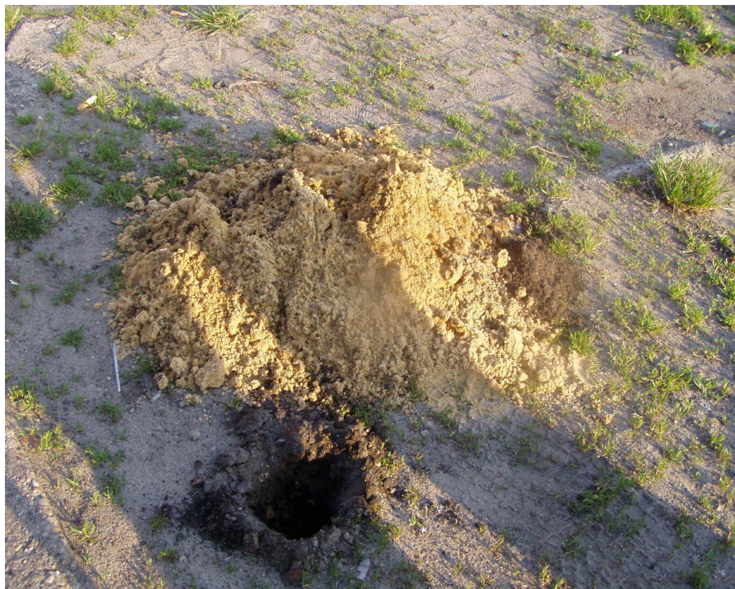
Wykonywanie odwiertów w istniejącej nawierzchni Odwiert nr 1, działka nr 1/4
