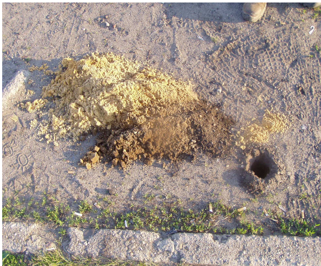
Wykonywanie odwiertów w istniejącej nawierzchni Grunt (20cm H/Ps + 230cm Pd)
