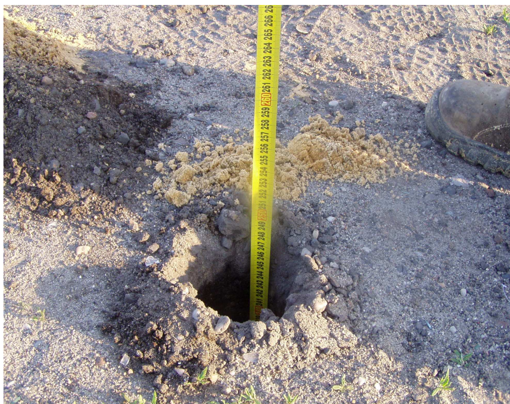
Wykonywanie odwiertów w istniejącej nawierzchni Odwiert do głębokości 2,50m p.p.t.
