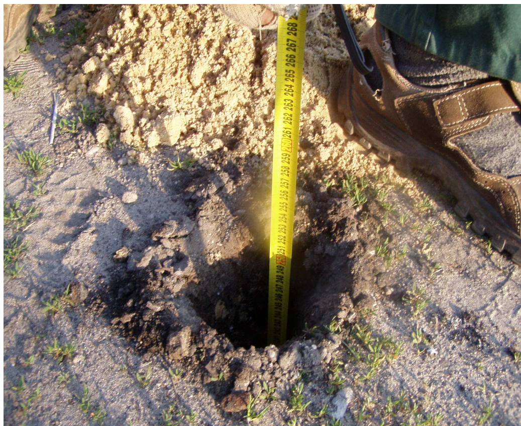
Wykonywanie odwiertów Odwiert do głębokości 2,50m p.p.t.
