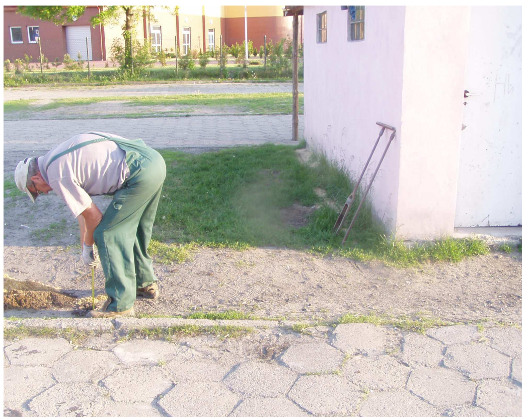
Odwiert nr 2, działka nr 1/3 Odwiert ręczny
