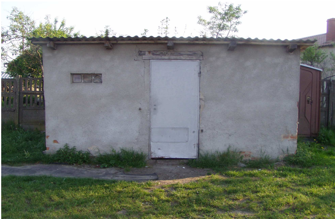
Budynek gospodarczy (nr 1) - elewacja boczna
