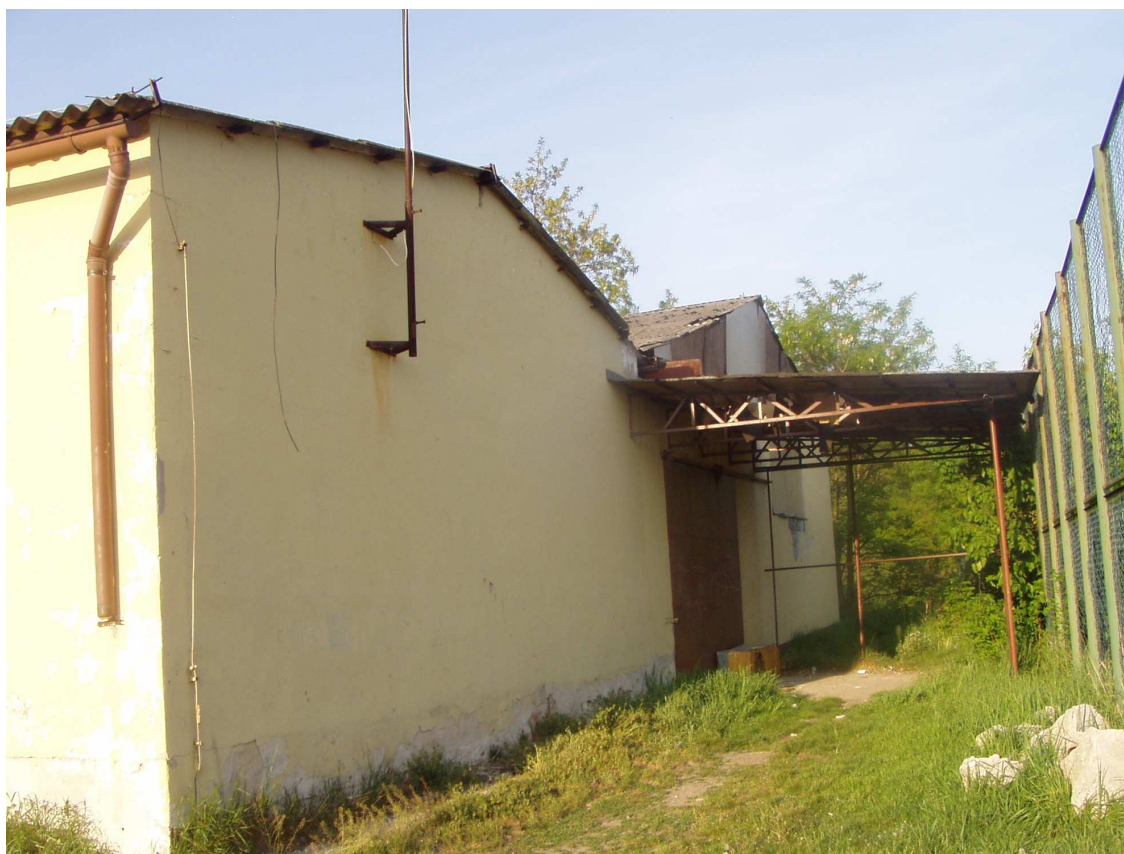
Budynek gospodarczy (nr 4) – elewacja frontowa
