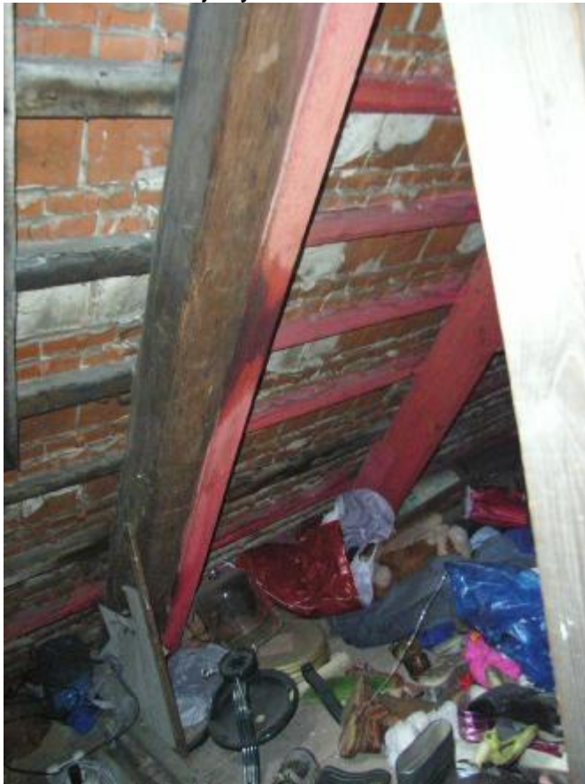
wieżba dachowa wzmocnienia
