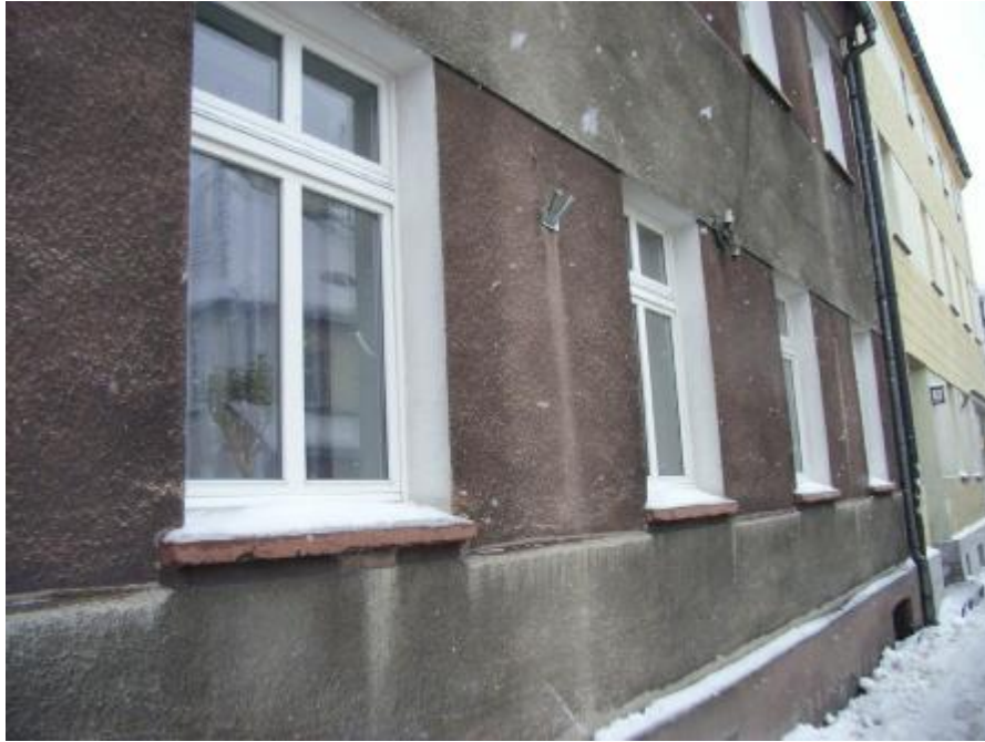
okna po wymianie
