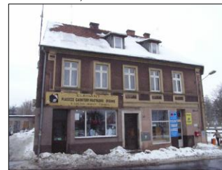
ul Ratuszowa nr 43 - Twardogóra elewacja frontowa od str ul.Ratuszowej
