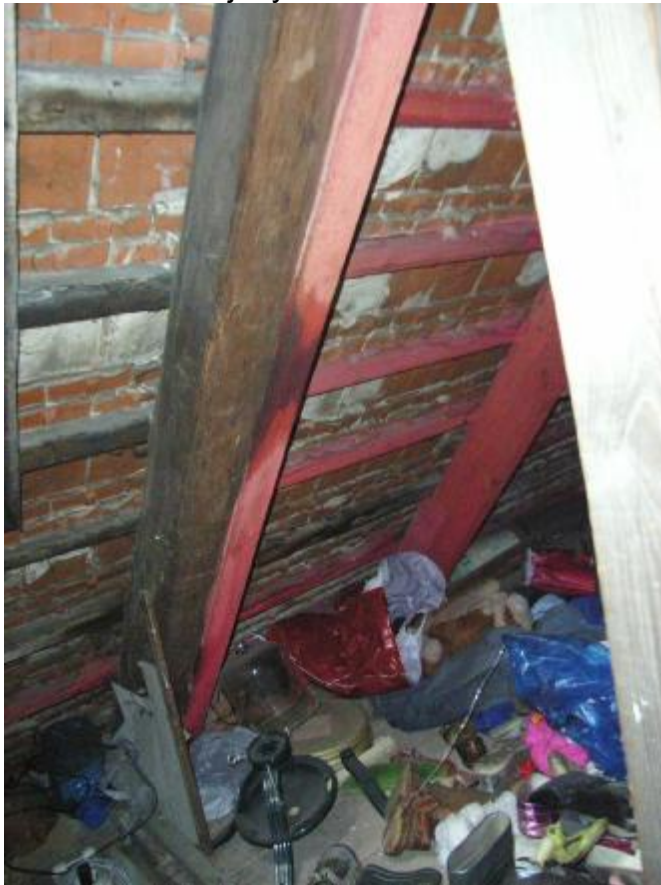
wieżba dachowa wzmocnienia
